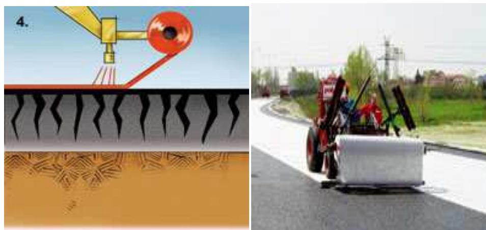
Joonis 36 Geotekstiili paigaldamine [9] [10]
