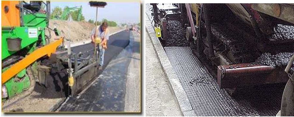
Joonis 44 Uue katte paigaldamine [6][8]
