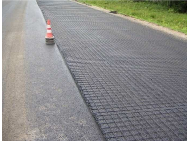
Joonis 48 Terasvõrgu elemendid on paigaldatud põiki
