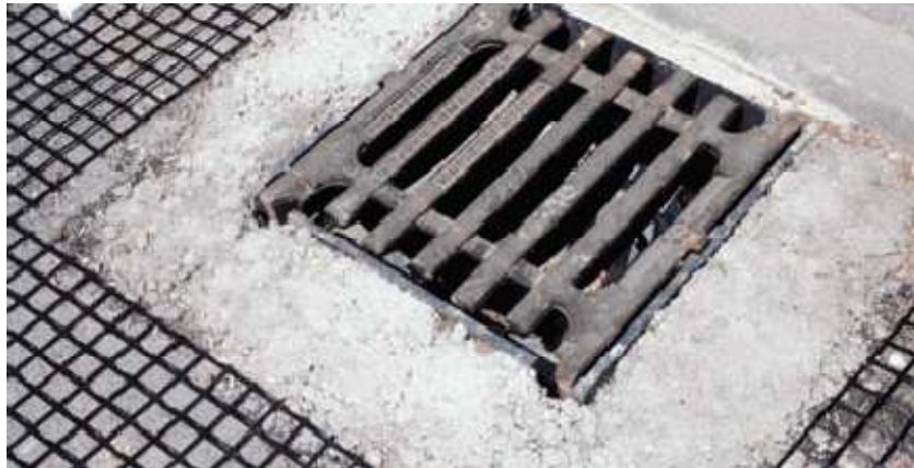
Joonis 47 Restkaevu armeerimine [3]
