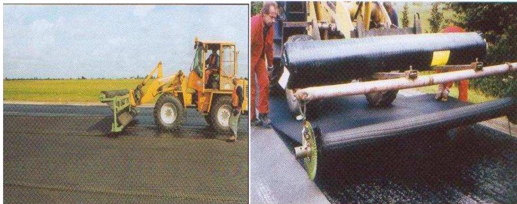
Joonis 42 Asfaldi geovõrgu paigaldamine [6] [7]
