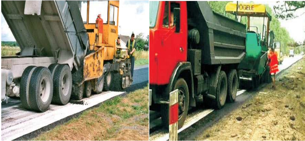
Joonis 38 Uue katte paigaldamine geotekstiili peale [9] [10]
