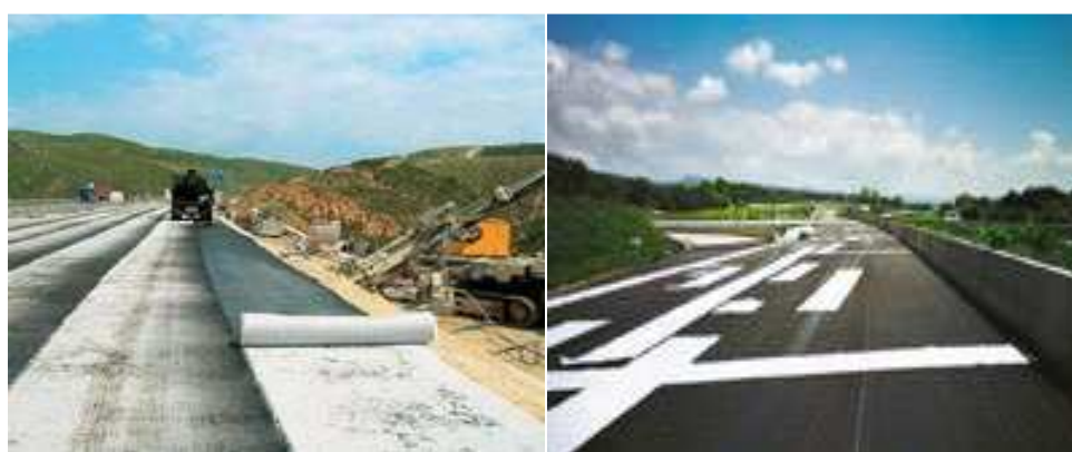
Joonis 37 Paigaldatud geotekstiil [10]
