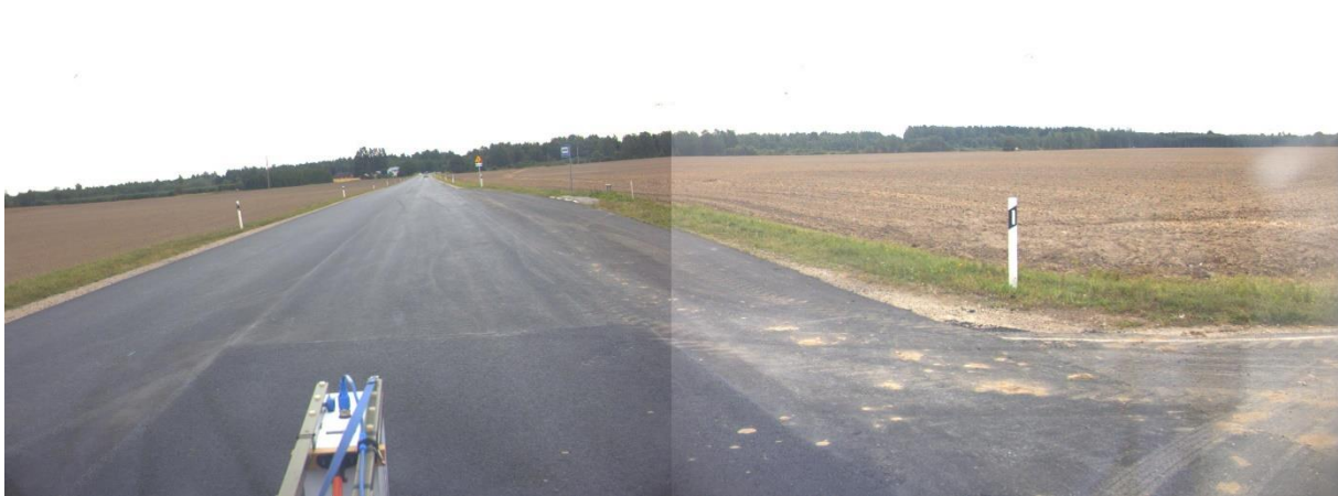
Pilt 1. Objekt 2_1_15 km 122,2
