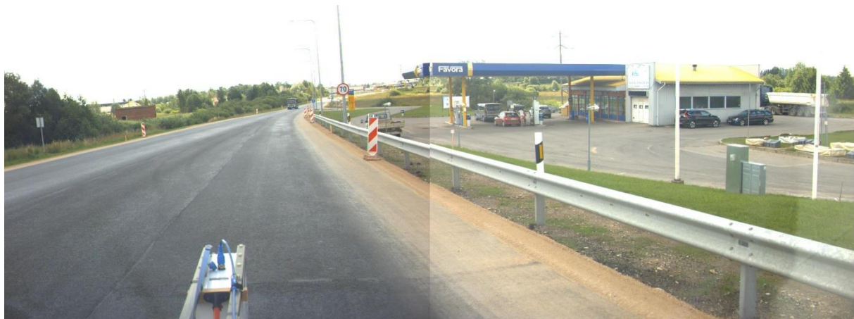
Joonis 28. Objekt 49_1_8 rada 1 km 48,6
