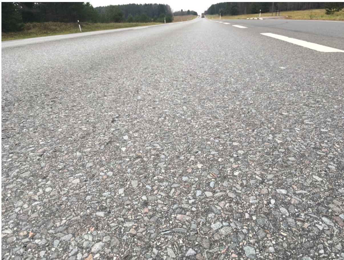
Joonis 5. Maantee 2 teeosa 8, AC16 seguga objekti üldvaade
