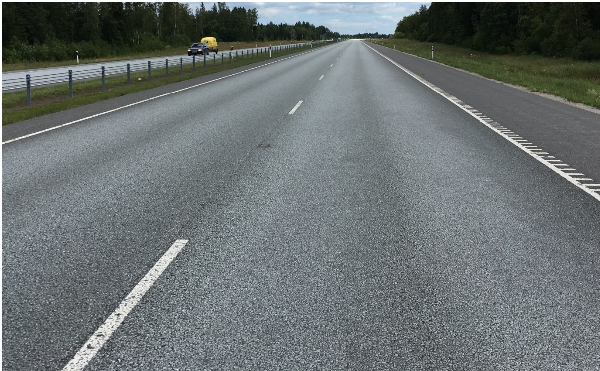
Joonis 1. Maantee 1 teeosa 10, SMA12 seguga objekti üldvaade
