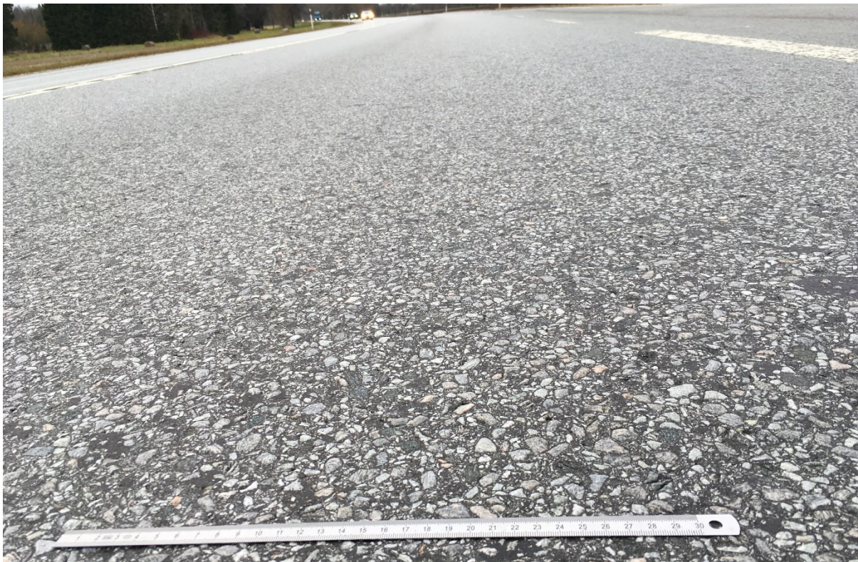
Joonis 7. Maantee 2 teeosa 7, AC12 seguga objekti üldvaade
