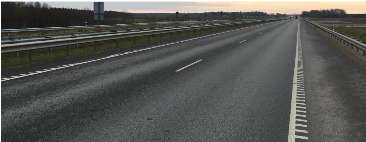
Joonis 3. Maantee 11 teeosa 4, SMA16 seguga objekti üldvaade
