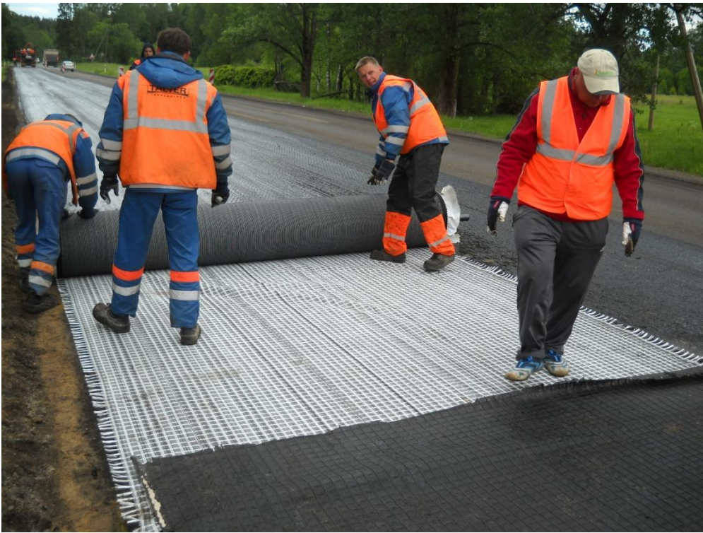
Foto 3. Paigaldatud HaTelit-võrk ja Glasstex-võrgu paigaldus
