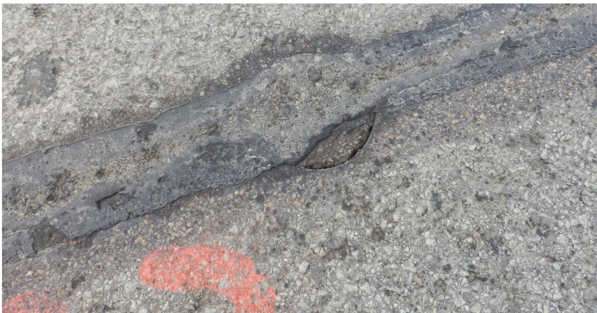
Joonis 32. Mastiksiga töödeldud pragu 2014 märtsi teises pooles
