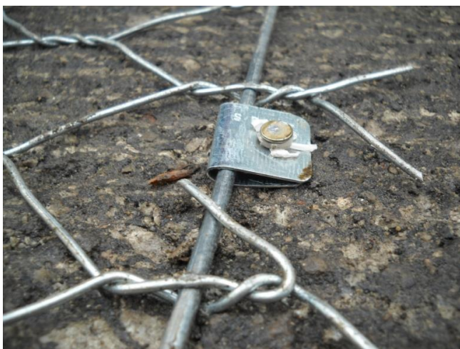
Joonis 14. Terasvõrgu RoadMesh kinnitusankur
