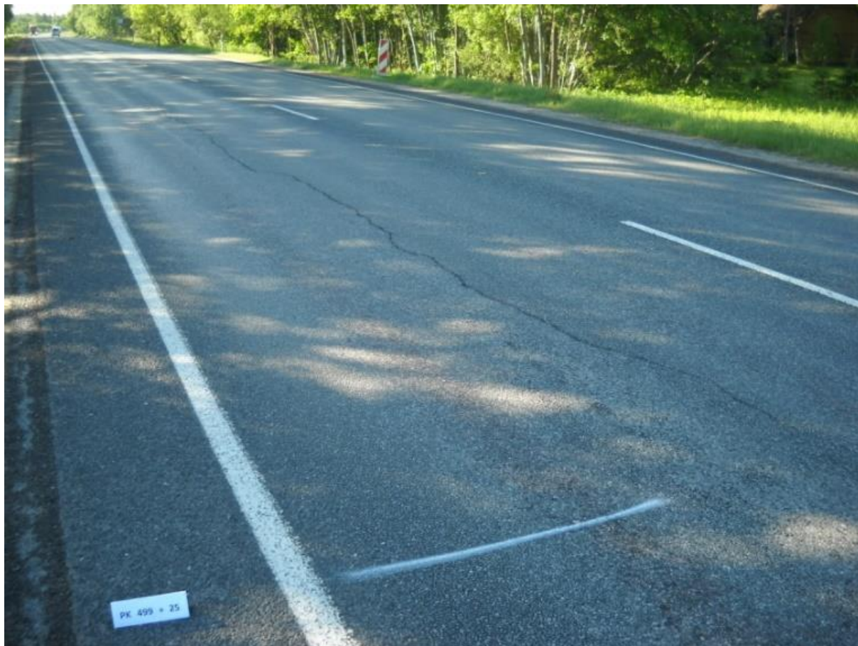
Joonis 3. Lai pikipragu kattes enne remonditööd 2010
