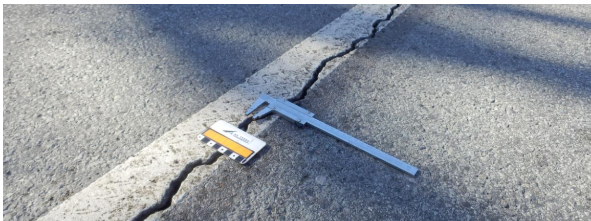
Joonis 27. Pragu 1 klaaskiudvõrguga lõigul 2013, 8...9 mm
