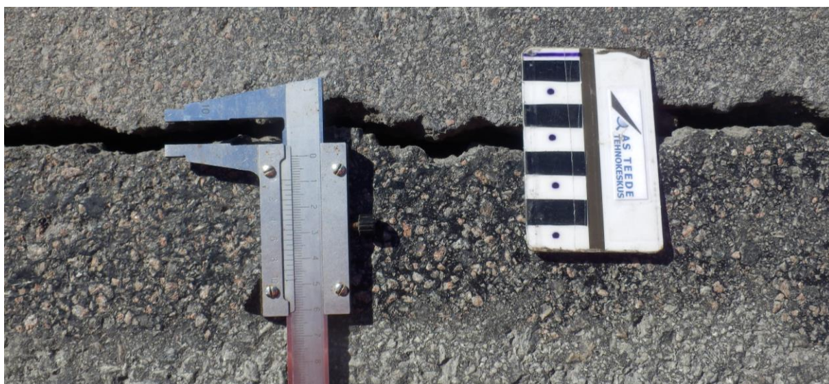
Joonis 28. Pragu 2 kevadel 2013 polüestervõrguga lõigul, 8...9 mm
