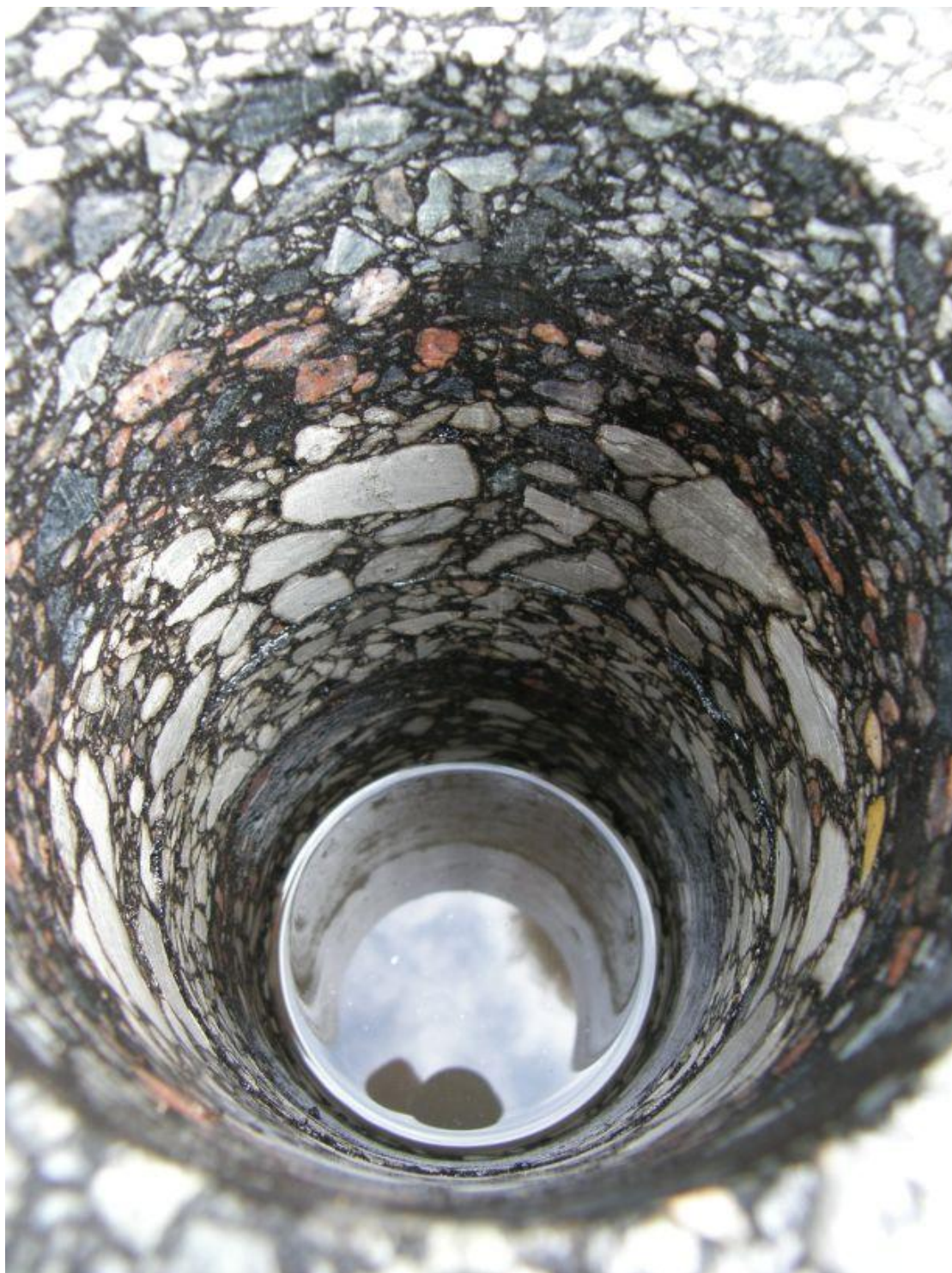
Foto 4. Puuruaugus C2 on näha Tensar Glasstex asfaldivõrgu serv 2011
