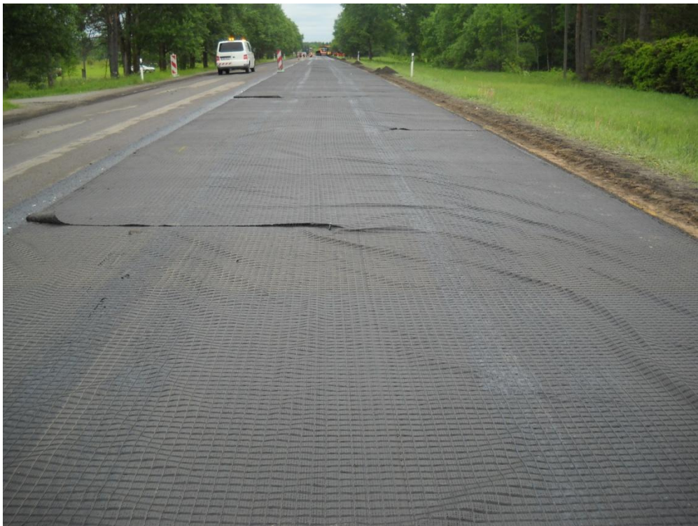
Foto 2. Hatelit võrgu lokkimine paigaldusel ja sisselõiked
