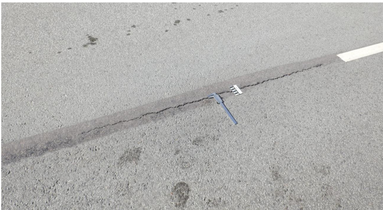
Foto 2. Uus, aastal 2013 avanenud pragu terasvõrguga lõigul
