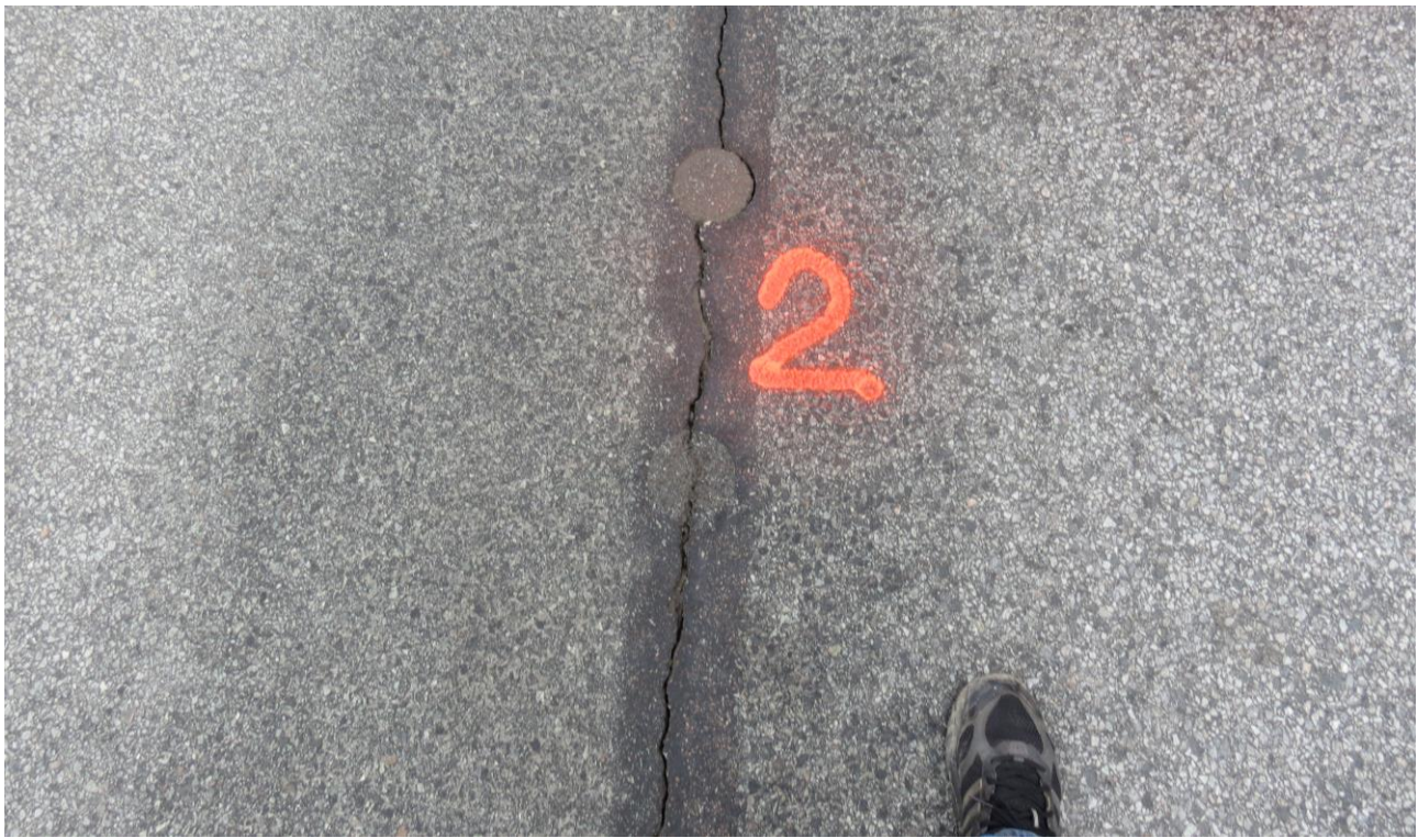
Foto 5. Pragu polüestervõrguga lõigul (foto Raxoest)
