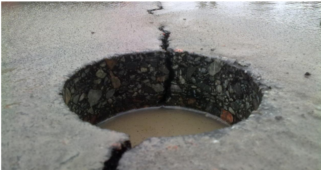
Joonis 18. Puurauk prao 1 uurimiseks
