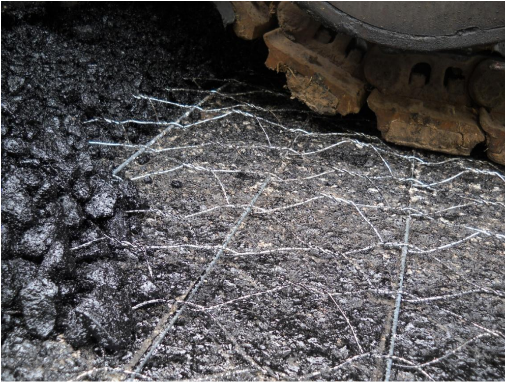
Foto 5. Asfaldivõrgu RoadMesh ülesurumine laoturi teo ees
