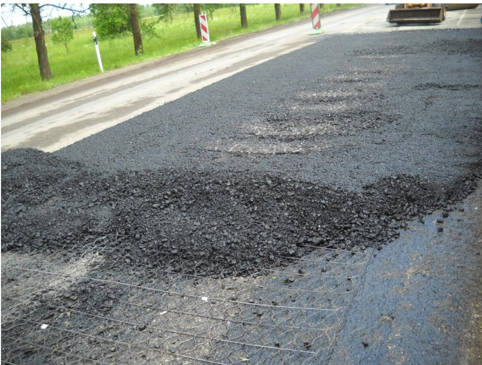
Foto 6. Ülessurutud ja eemaldamisele kuuluv RoadMesh
