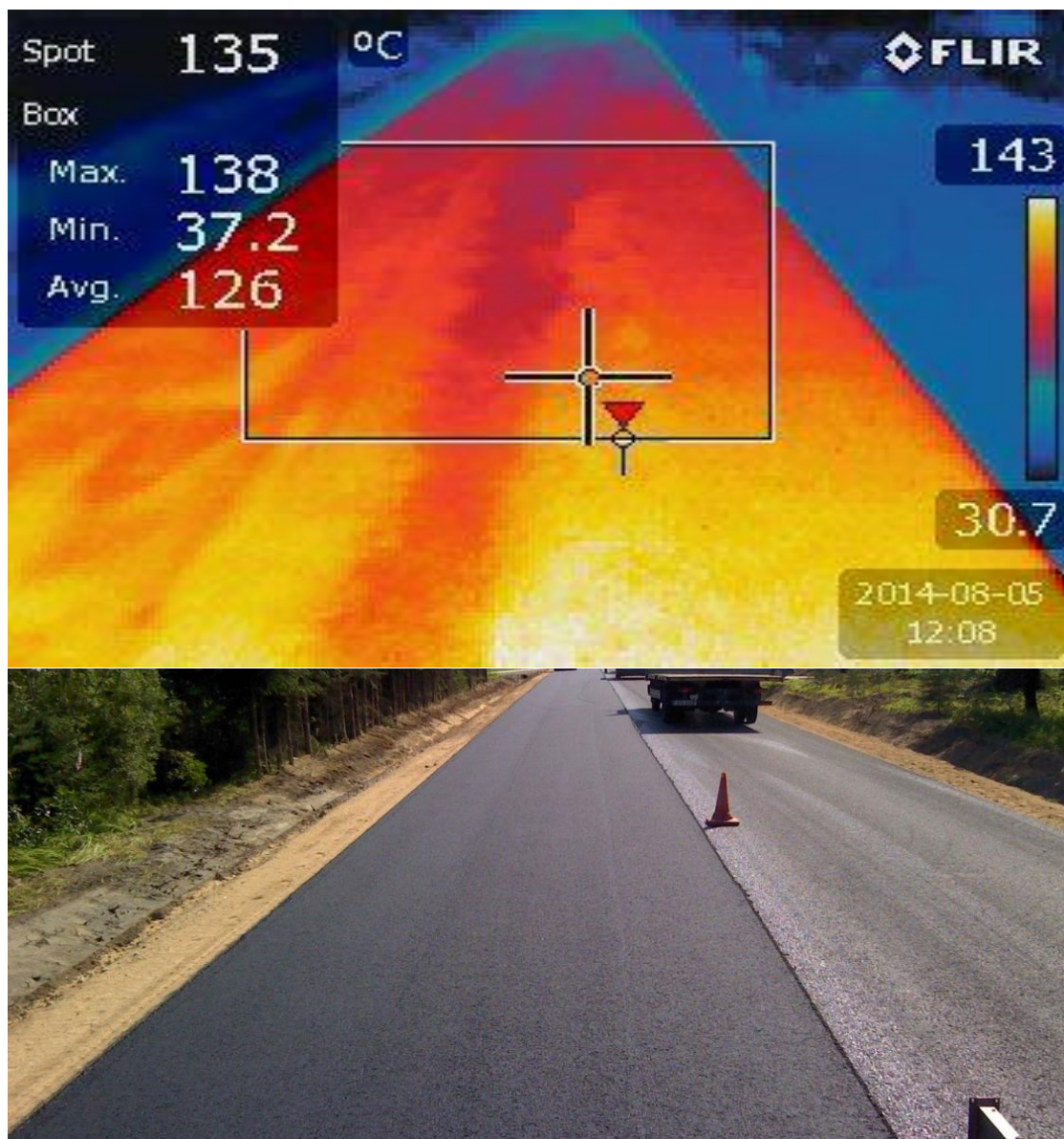
Joonis 34. Vaade laotatud paanile laoturi tagant
