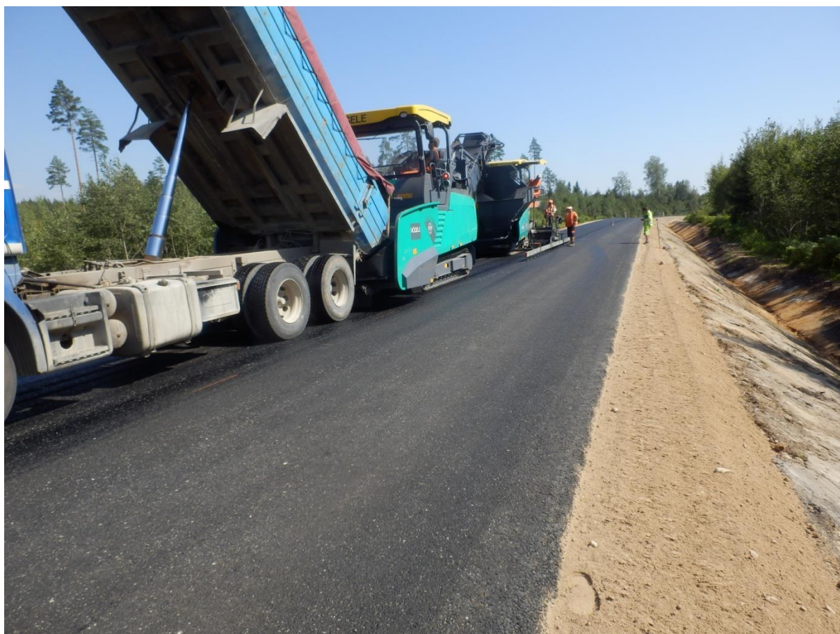
Joonis 8. Asfaltsegu laotamine söötjaga varustatud uuringuobjektile
