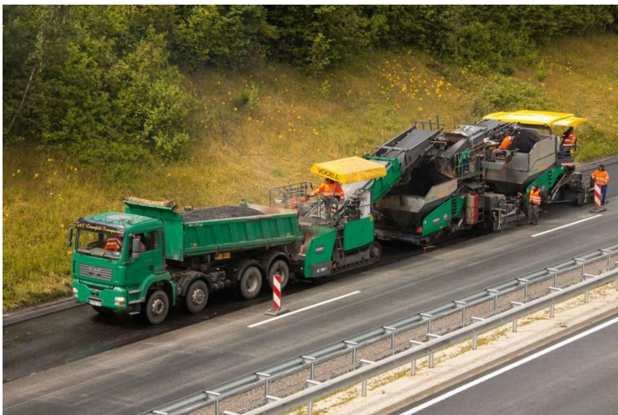
Joonis 6. Voegle „feeder“-tüüpi asfaldilaoturi söötja tööprotsessis
