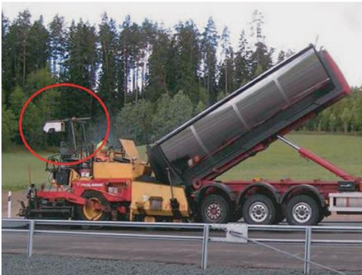
Joonis 5. Termoskaneerimise seade
