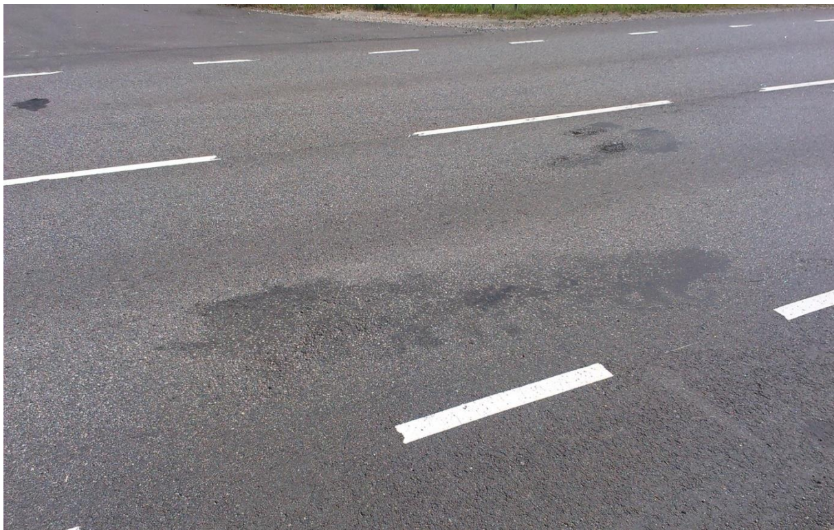
Joonis 2. Asfaltkatte lagunemise näide samal maanteel Roelas
