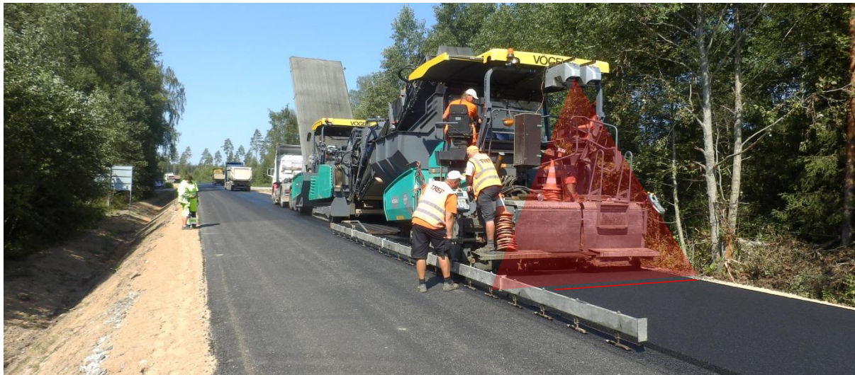
Joonis 11. Termoskaneerimine laoturi tagant
