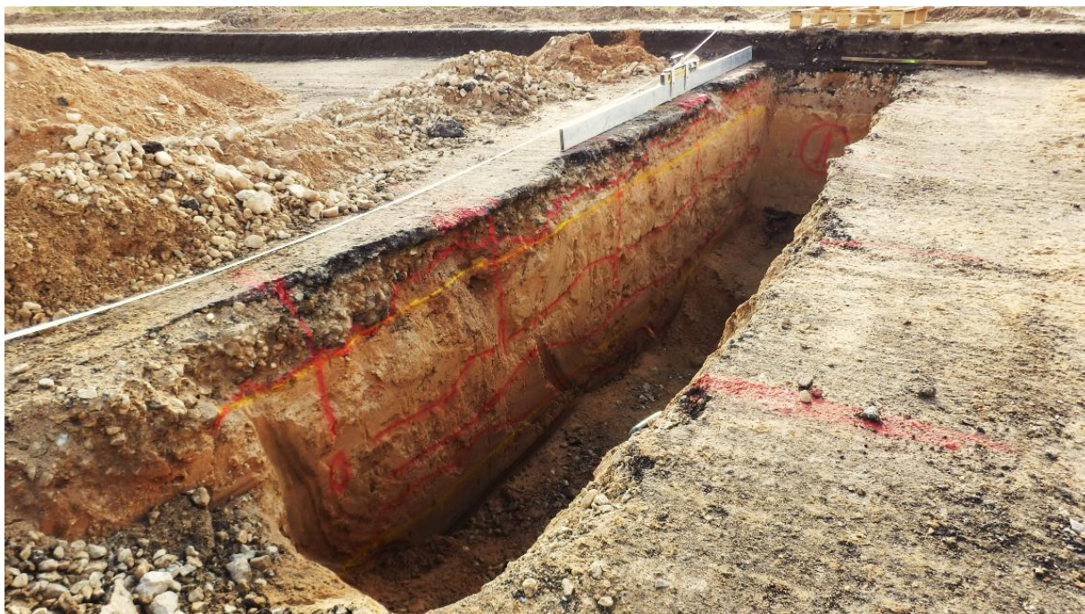
Foto 12. Kihtide ja vertikaalsete abijoonete märkimine surfis
