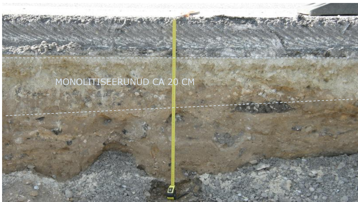
Joonis 10. Monolitiseerunud alus maanteel 15 Luigel
