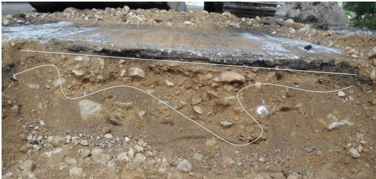
Joonis 9. Kruusalus Aruvalla-Kose ehitusobjektil
