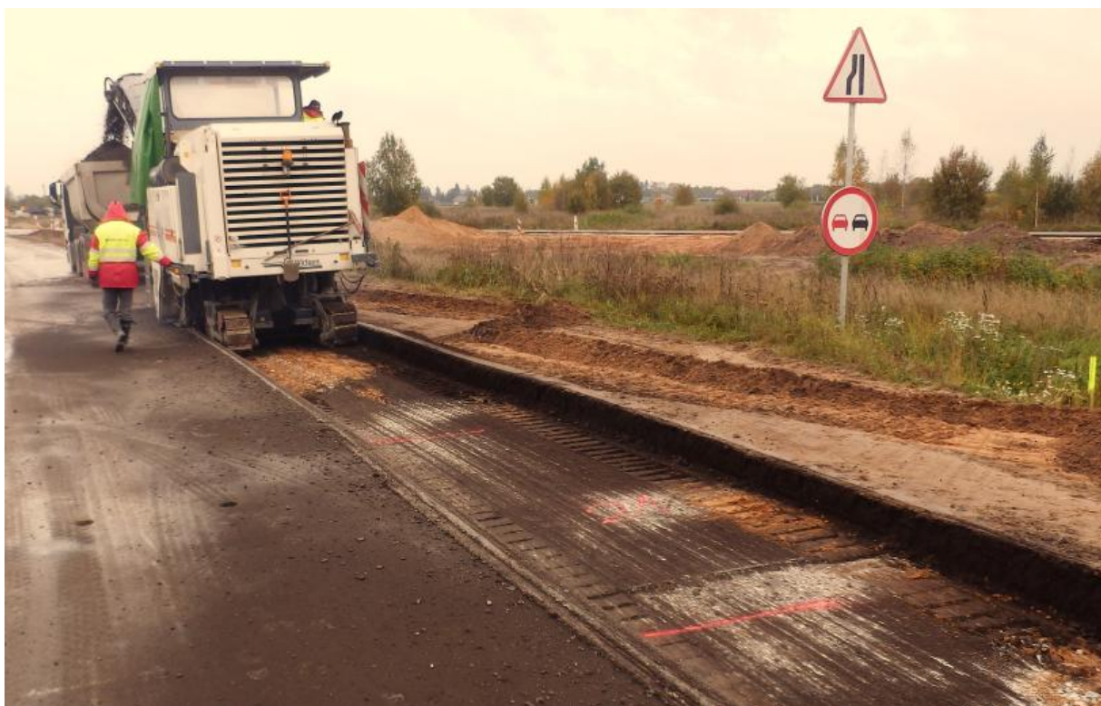
Foto 8. Katte freesimine uuringukohas
