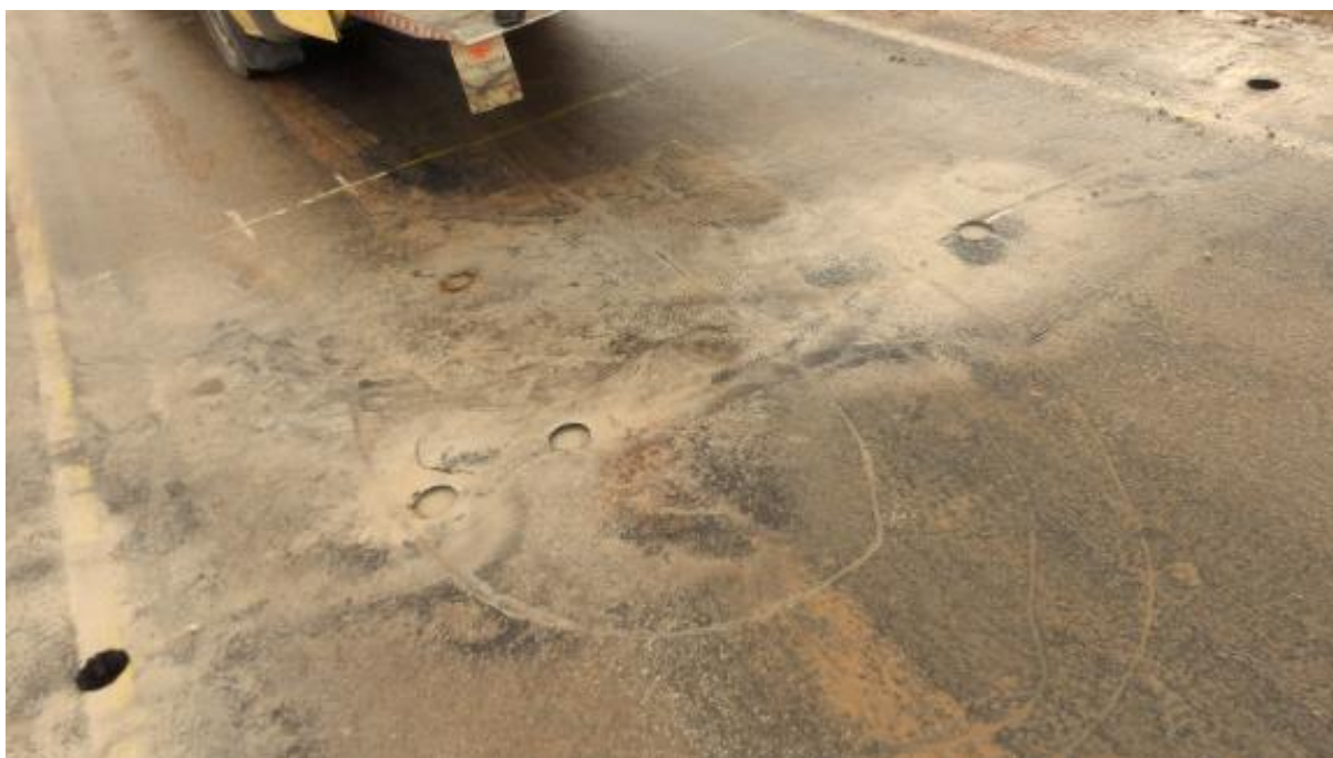
Foto 6. Puuritud kate ja vee püsimine osades puuraukudes Postimaja objektil
