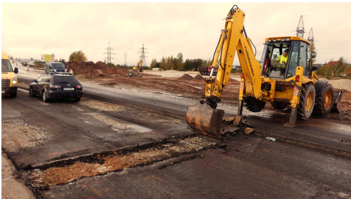
Foto 10. Katte eemaldamine uuringukohalt
