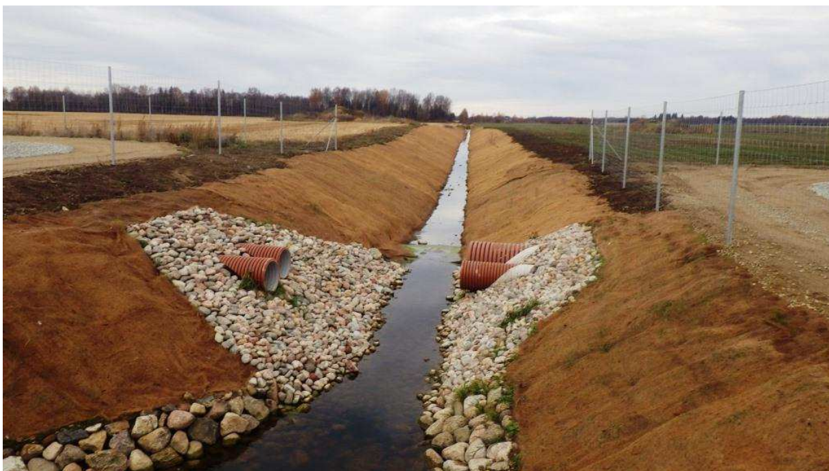
Foto 9. Kurna oja kindlustamine erosioonitõkkematiga
