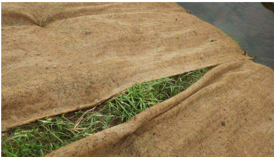
Foto 10. Kurna oja erosioonitõkke mati paigaldamine murustunud nõlvale
