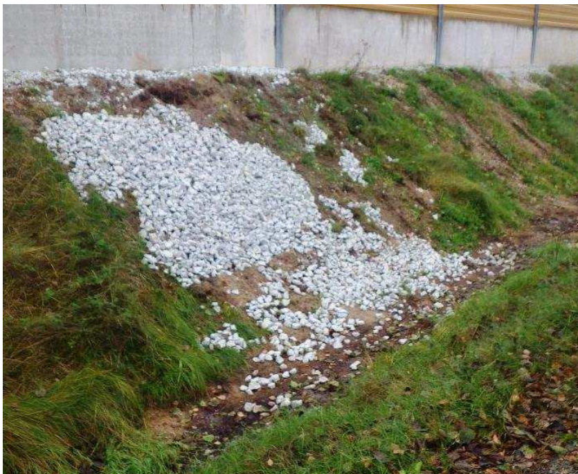
Foto 3. Killustikuga parandatud kraavi kaldad
