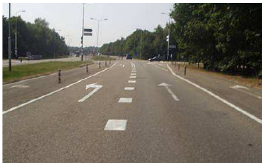
Ristmiku kompaktsemaks muutmise sõiduradade arvu vähendamise abil (kõige odavam abinõu)
