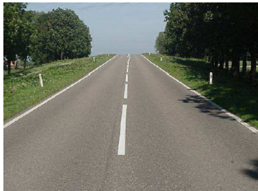
Kumer püstkõverik: normidele vastav nähtavuskaugus
