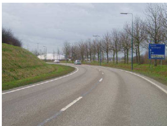
Piiratud nähtavuskaugus horisontaalse käänaku korral
