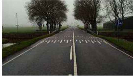
Kiirusepiirang 50 km/h, kiiruse vähendamiseks paigaldatud kõrgend, tugimaanteel (maapiirkonnas)
