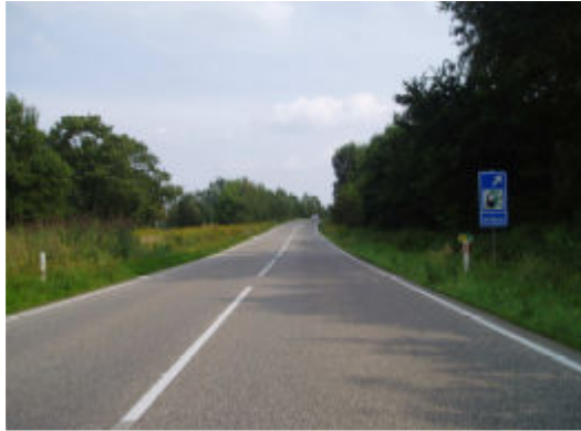
Püst- ja pikikõverikuga plaanikõverik
