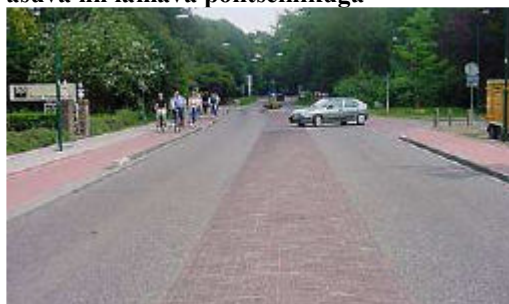
Liikluse rahustamine kitsamate sõiduradade ja eraldusribaga
