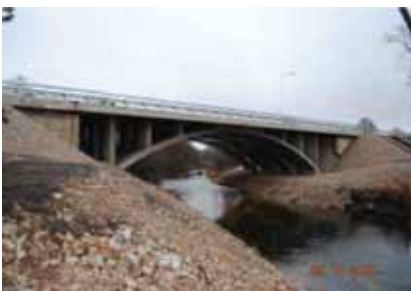
Lüganuse ja Roodu sildade rekonstrueerimine
