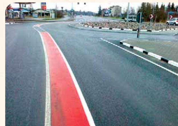
Road No. 9, Ääsmäe-Haapsalu-Rohuküla, km 64,46–70,416.
