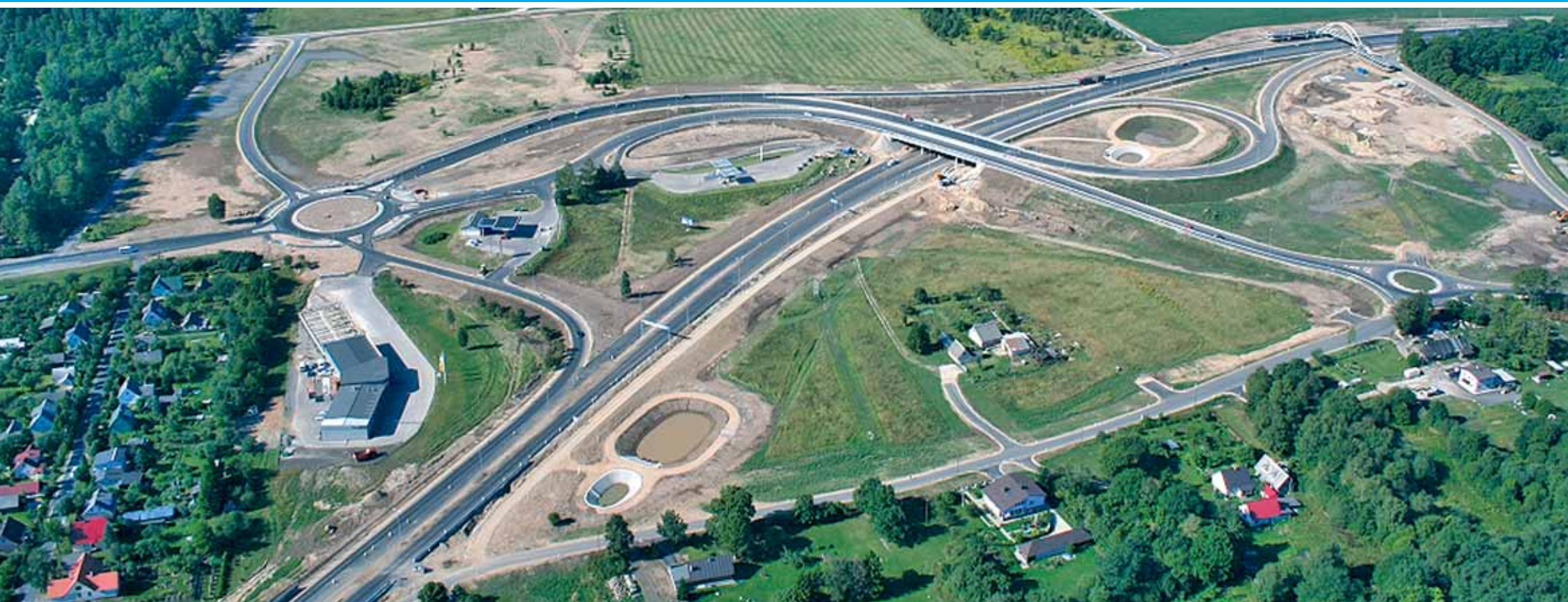
Esikaane foto: Taivo Möll (objekt: Mäo liiklussõlm, töövõtja Nordecon AS)
