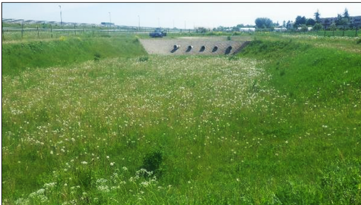
Foto 10. Kukruse-Jõhvi V süsteem, immutusbassein (05.06.2019)
