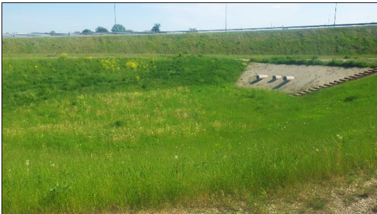
Foto 4. Kukruse-Jõhvi II süsteem, immutusbassein (05.06.2019)
