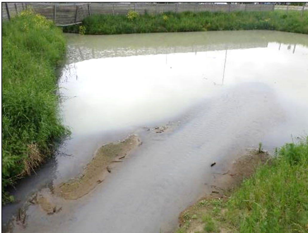
Foto 2. Kroodi settebasseini on edelapoolse sissevoolu kaudu kantud suur kogus liivaseid setteid (14.06.2019)
