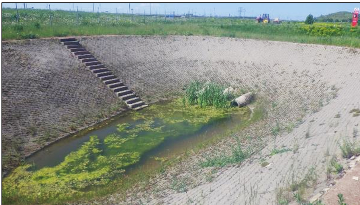
Foto 13. Kukruse-Jõhvi VI süsteem, taimestik takistab vee väljavoolu settebasseinist (05.06.2019)
