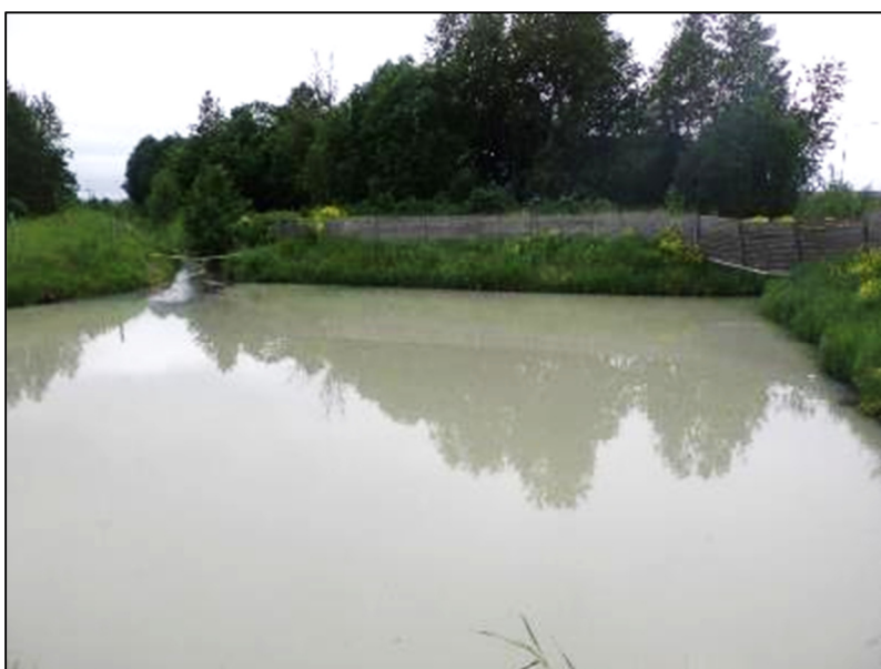
Foto 3. Kroodi settebasseini vesi oli proovivõtu päeval valkjashall ja hägune. Fotel vasakul edelapoolne ehk peamine sissevool (14.06.2019).
