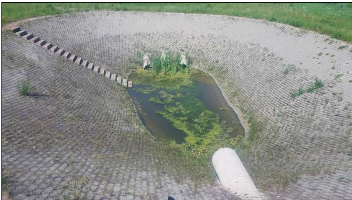
Foto 11. Kukruse-Jõhvi VI süsteem, settebassein (05.06.2019)
