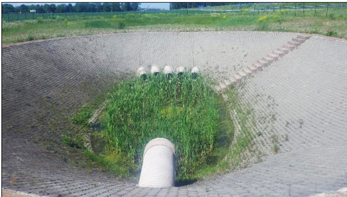
Foto 9. Kukruse-Jõhvi V süsteem, settebassein (05.06.2019)
