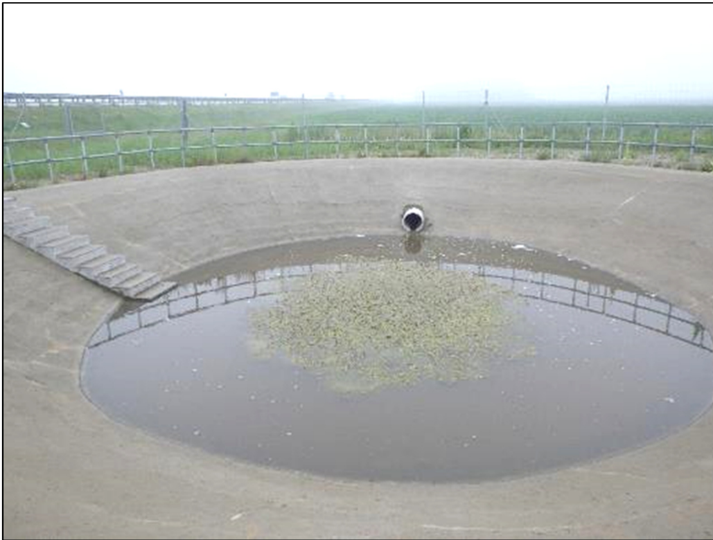
Foto 3. Kurna II süsteem, settebassein (14.06.2019)
