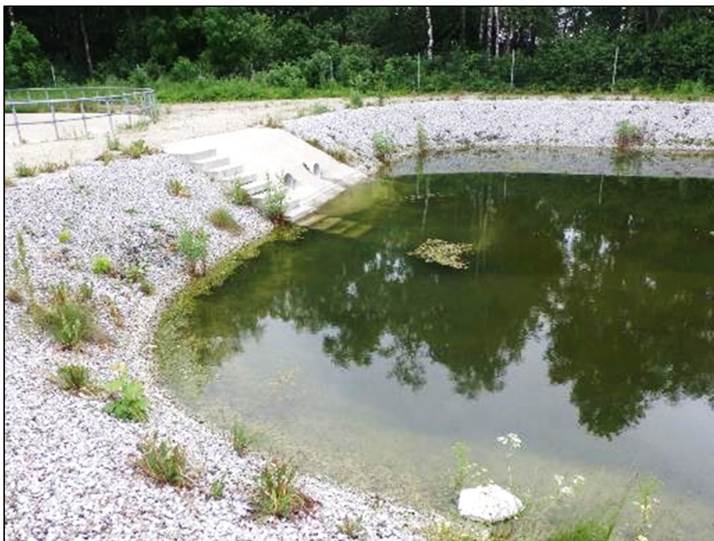
Foto 4. Kurna-Luige teelõigu immutusbasseinide vesi oli proovivõtu ajal selge ja läbipaistev. Fotel Kurna V sademeveesüsteemi immutusbassein (14.06.2019).
