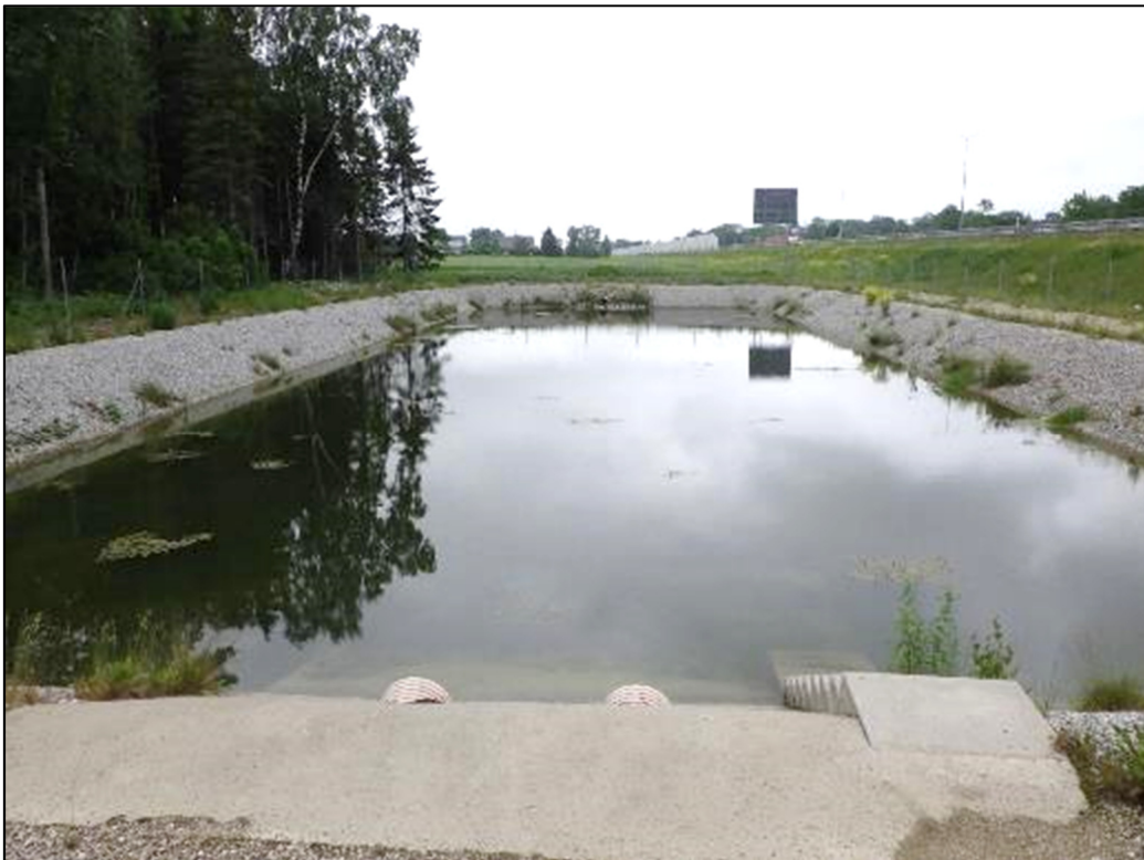
Foto 11. Kurna V süsteem, immutusbassein (14.06.2019)
