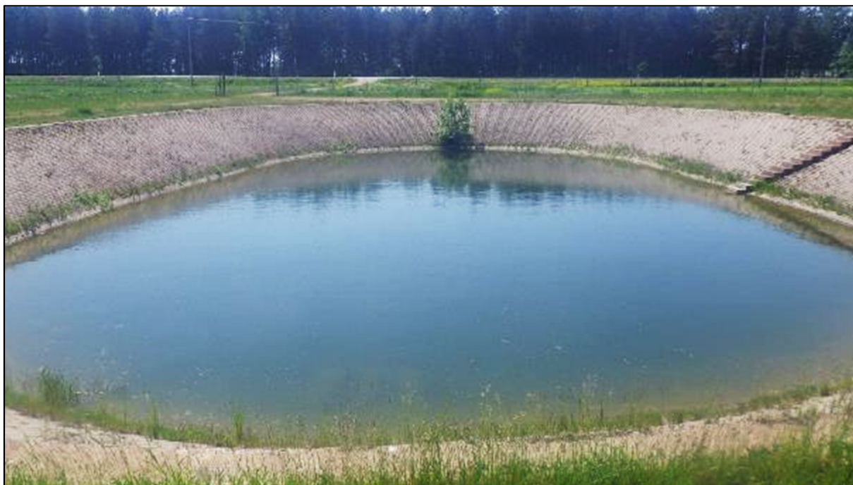
Foto 15. Kukruse-Jõhvi VII süsteem, settebassein (05.06.2019)
