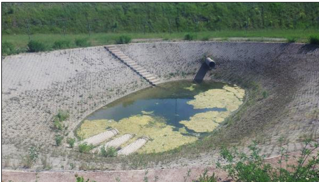
Foto 3. Kukruse-Jõhvi II süsteem, settebassein (05.06.2019)
