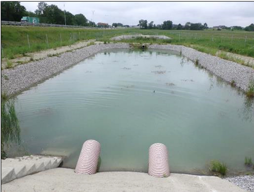
Foto 6. Kurna III süsteem, immutusbassein (14.06.2019)
