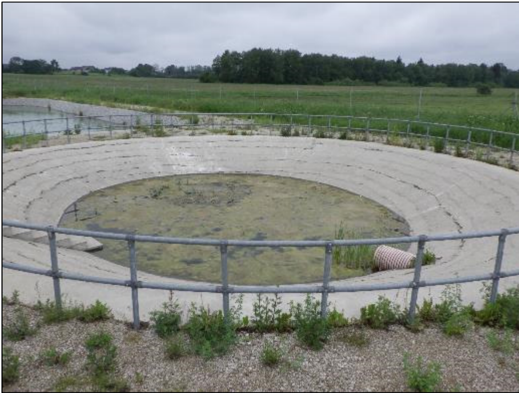
Foto 5. Kurna III süsteem, settebassein (14.06.2019)
