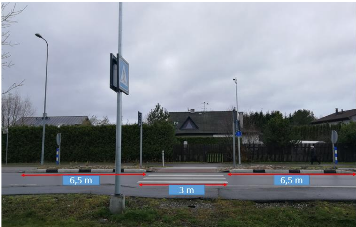
Joonis 4. Vaatlusobjekti tee ristlõike elementide mõõtmelised väärtused, vaade 2
