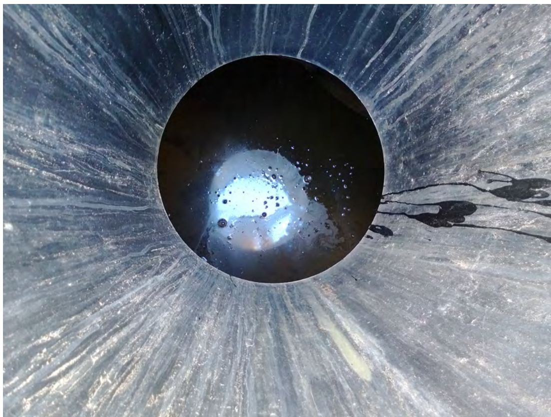
17 Sademevee kollektorkaevu 16 toruotsad olid vee all, vesi reostustunnusteta, sete hall suspensioonilaadne
