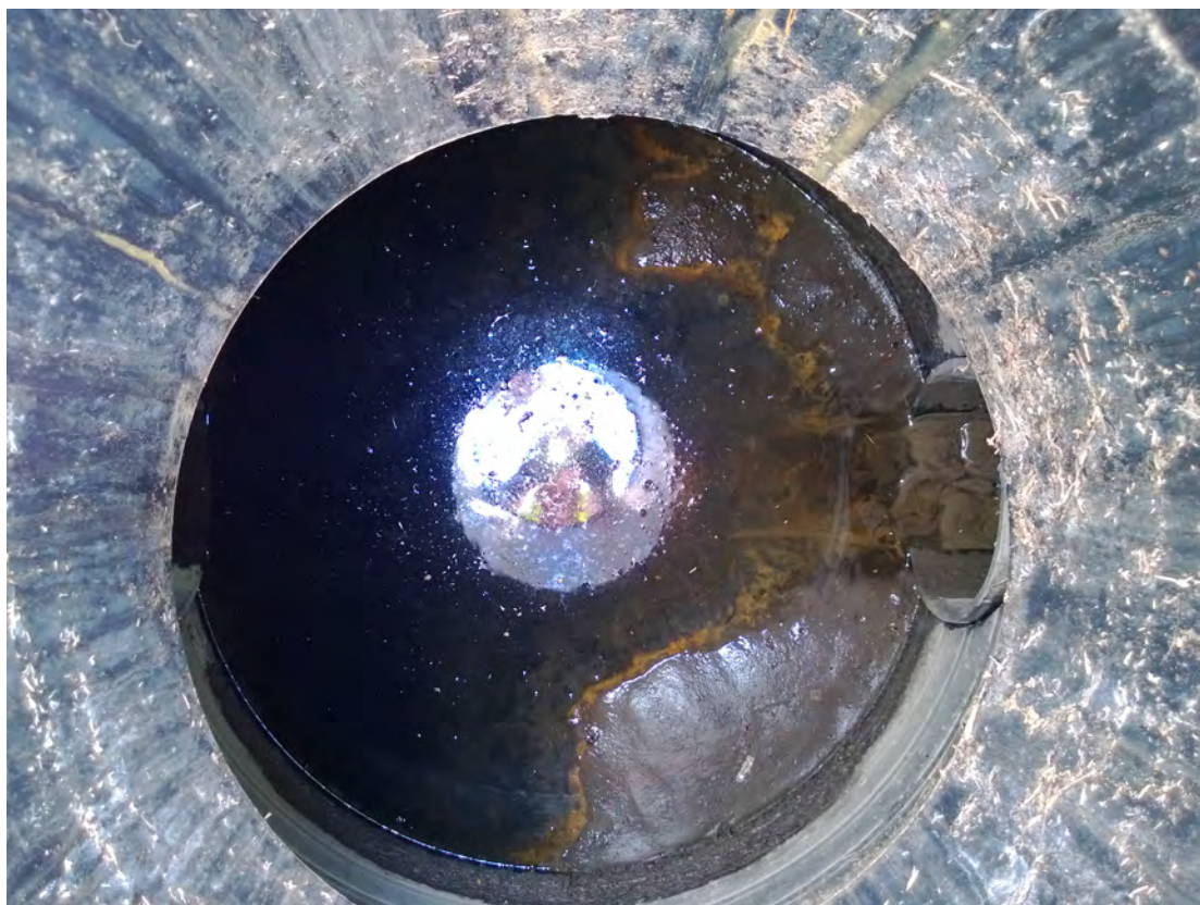
8 Sademevee kollektorkaevu 7 vesi ja pinnas olid naftasaadustega reostunud
