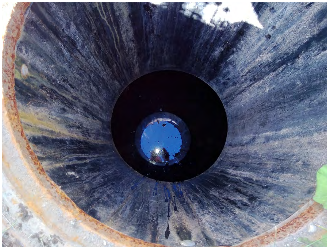
19 Sademevee kollektorkaev 18 toruotsad olid vee all, veepinnal üksikud õlitilgad, ei lõhna naftasaaduste järgi,
