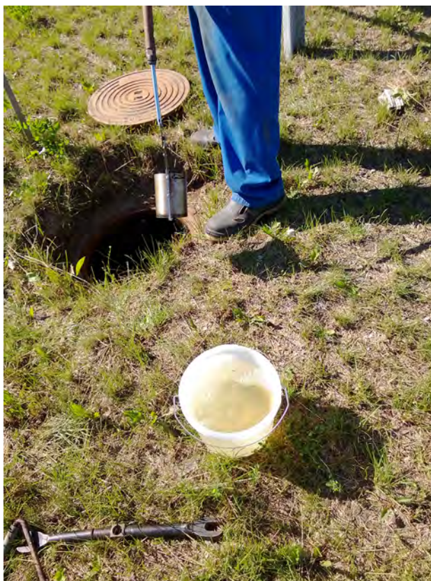
21 Sademevee kollektorkaev 20 toruotsad olid vee all, vesi reostustunnusteta
