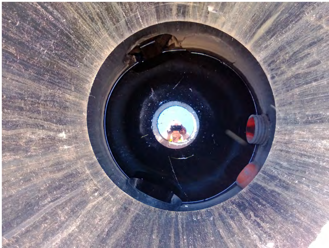
3 Vaade sademevee kollektorkaevu 1
