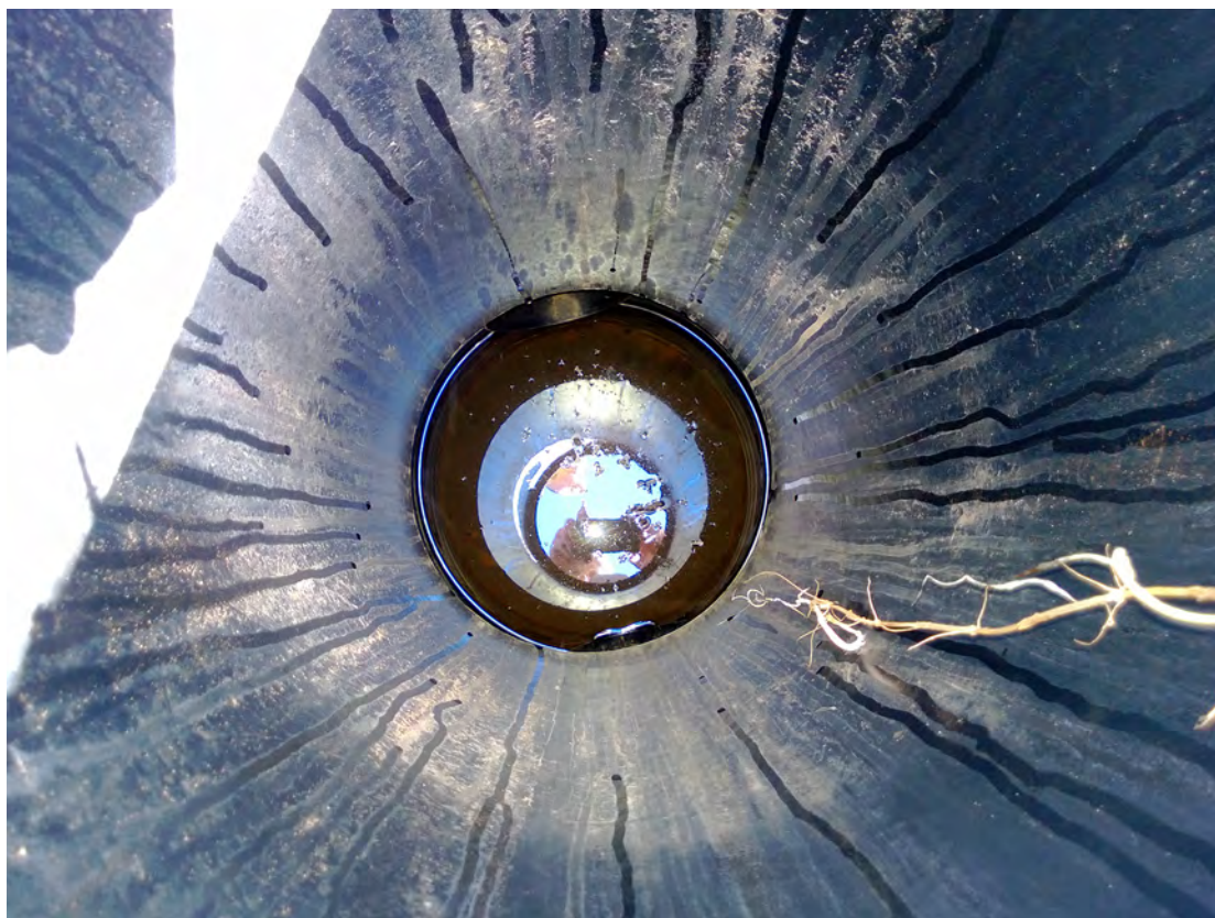
13 Sademevee kollektorkaev 13 veel õrn raua või õlikile, setet praktiliselt pole
