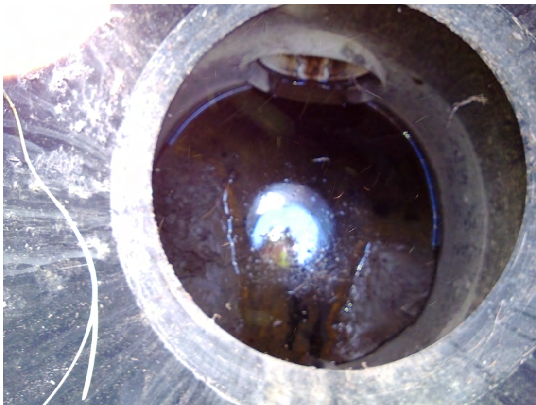
15 Sademevee kollektorkaevus 15 oli palju pinnast ja vähe vett, otseste reostustunnusteta
