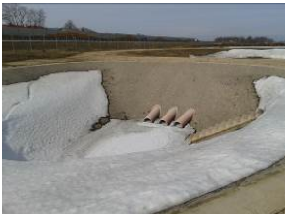
Foto 8. Kukruse-Jõhvi IV süsteem, vaade liivapüüdurile
