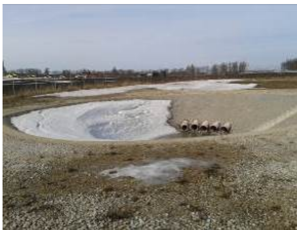
Foto 10. Kukruse-Jõhvi V süsteem, vaade liivapüüdurile
