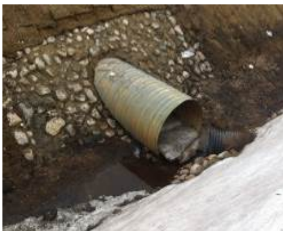
Foto 51. Maantee alt tuleva truubi sissevool kraavi ja kraavist väljavool läänepoolsesse settebasseini
