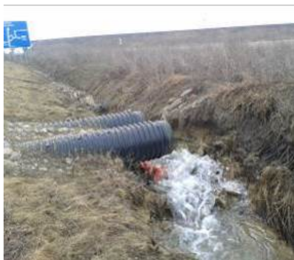
Foto 29. Maanteetruubi väljavool binokkeltruubist
