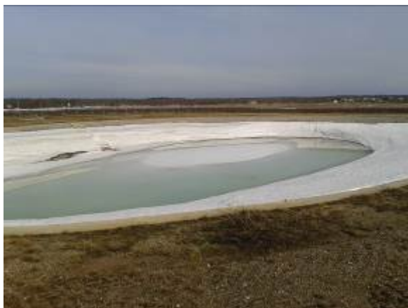
Foto 14. Kukruse-Jõhvi VII süsteem, vaade liivapüüdurile
