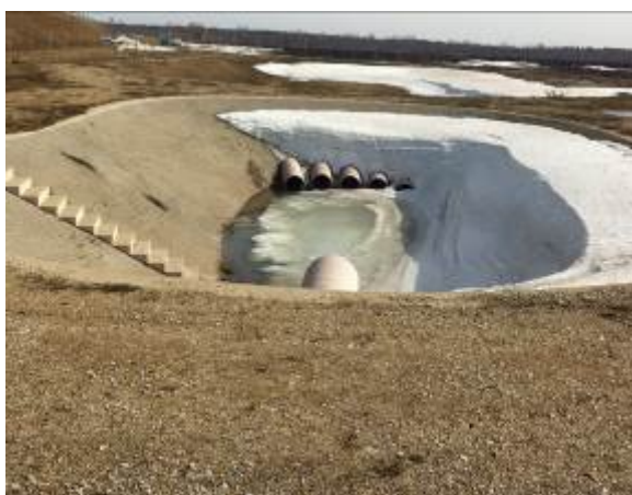
Foto 6. Kukuruse-Jõhvi III süsteem, vaade liivapüüdurile
