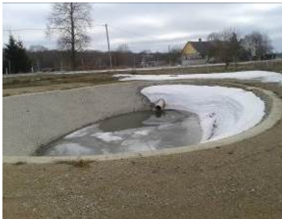
Foto 2. Kukuruse-Jõhvi I süsteem, sissevool liivapüüdurisse
