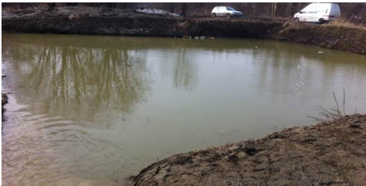
Foto 25. Pirita. Vaade liiva-õlipüüduri sissevoolu juurest
