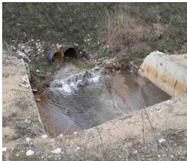
Foto 34. Maardu. Vaade truubitoru väljavoolule, kus esineb ebameeldiva lõhnaga vesi
