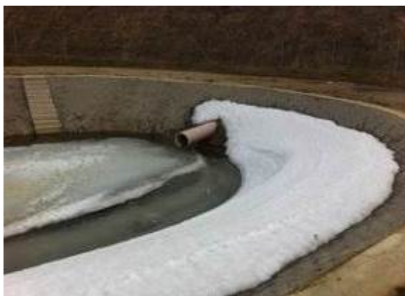
Foto 4. Kukuruse-Jõhvi II süsteem, sissevool liivapüüdurisse
