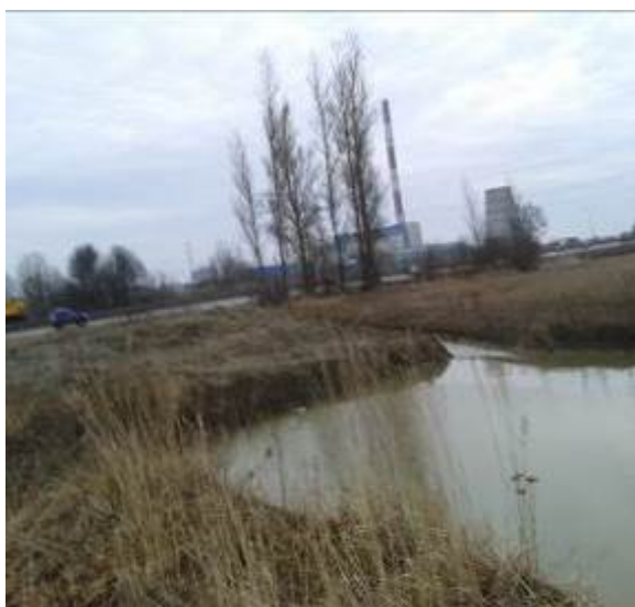
Foto 26. Pirita. Vaade liiva-õlipüüdu sissevoolul
