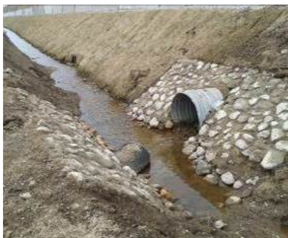
Foto 52. Maantee alt tuleva truubi sissevool kraavi ja kraavist väljavool idapoolsesse settebasseini
