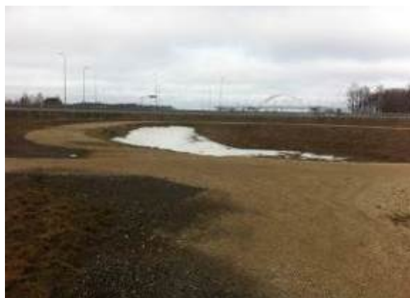
Foto 5. Kukuruse-Jõhvi II süsteem, immutusbasseini sissevool liivapüüdurist
