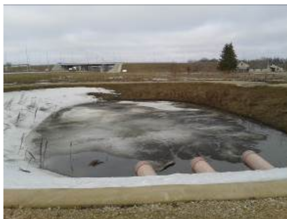
Foto 3. Kukuruse-Jõhvi I süsteem, immutusbasseini sissevool liivapüüdurist
