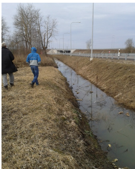
Foto 31. Sissevoolukraav õli- ja liivapüüdurisse
