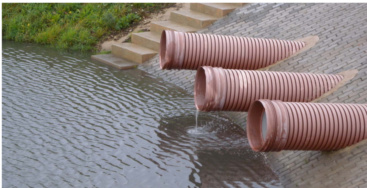
Foto 1 Jõhvi teeristis sademeveesüsteemi suure basseini sissevool liiva-õlipüüdurist (11.10.2011)
