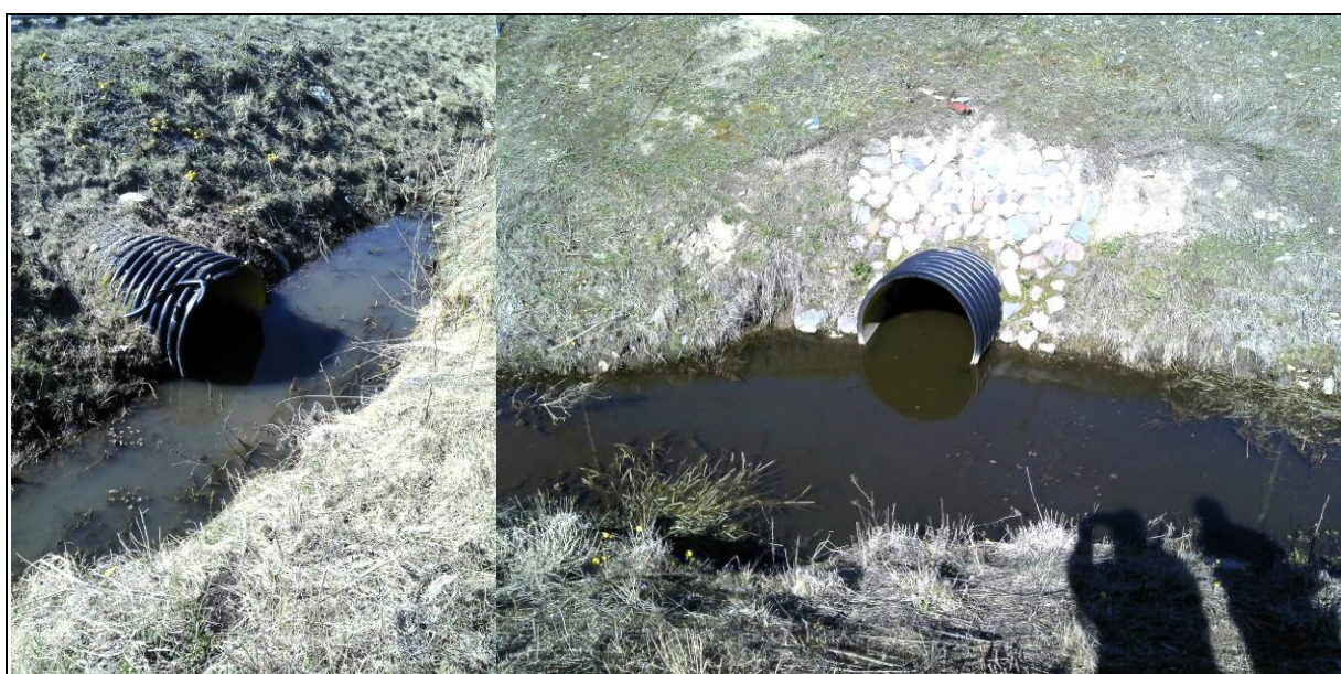
Foto 10 Peterburi teest lõunas olevate kogujateede truubid (vasakul sissevool, paremal väljavool)
