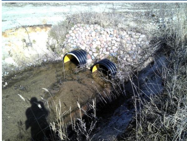
Foto 4 Õli-liivapüüdurisse edela poolt suubuval kraavil paikneva kaksiktruubi truubi sissevool, vesi selge ja läbipaistev
