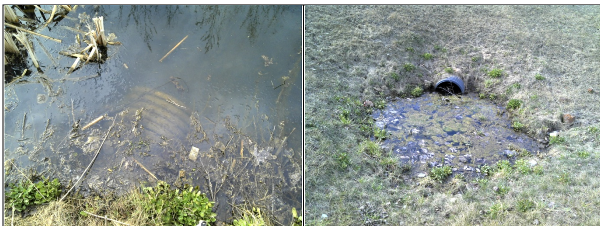
Foto 2 Vasakul uputatud truubisuue õli-liivapüüdurist põhjapool paiknevas kraavis, paremal väike lohk truupi sissevoolul, kuhu kogunevad veed õli-liivapüüdurist põhjapool ringtee piirkonnast
