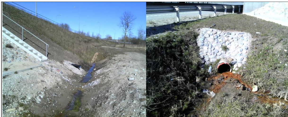
Foto 12 Läänepoolse kraavi kogujatee kraav viadukti juures ja kogujatee alt läbiviidud truup ja sinna siseneva kraavi rauarikas vesi
