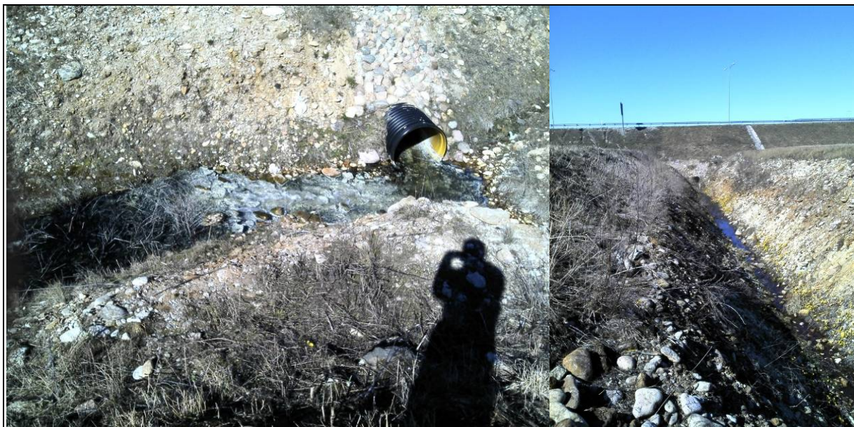
Foto 11 Vasakul kogujateest lõunapool kraavivee suubumine truupi, mis väljub enne Peterburi teeäärset raudteed. Paremal kagu suunast tulev valdavalt kuiv kraav (taga lõunapoolse kogujakraavi kraavivee suubumine truupi)
