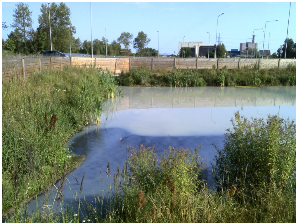
Foto 18 Kroodi õli-liivapüüdur 07.08.2014, näha on juuli lõpus sadudega lisandunud liiv
