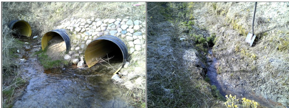
Foto 5 Põhjaranna tee alt edelapoolsesse kraavi suubuvad truubid. Vasakpoolsem truup on sissevool kraavist, mis algab raudtee kõrvalt naftabaasi tagant, (ca 200m kaugusel truubist veevool praktiliselt lakkab, parempoolisel pildil).
