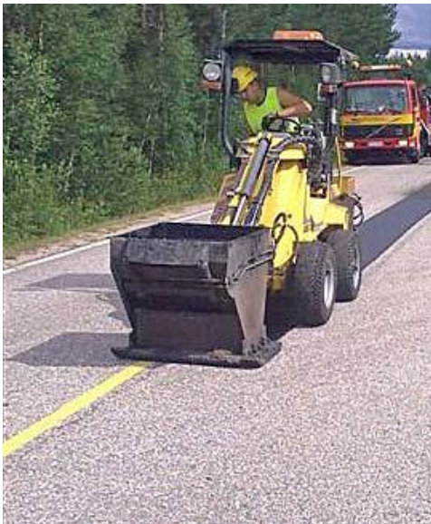
Pilt 6. MT- valuasfalt paikamise laotamine, tihendamine ja karestatud paik
