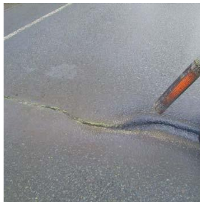
Pilt 12. Puhuriga kuumutamine
