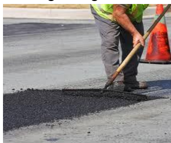
Pilt 3. Asfaltbetoonpaikamine käsitsi meetodil
