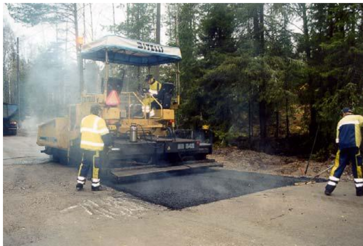
Pilt 4 Mehhaniseeritud asfaltbetoonpaikamine
