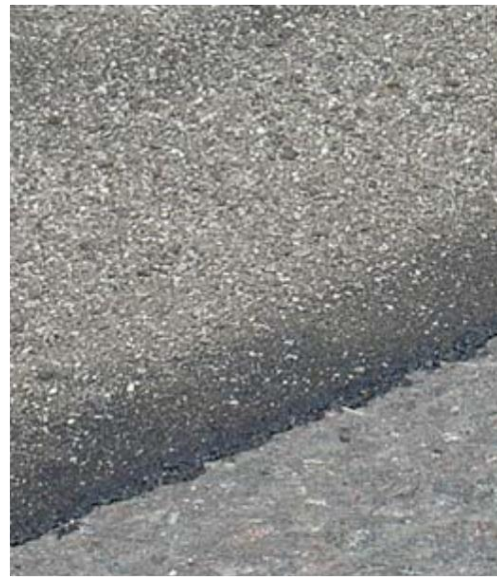
Pilt 6. MT- valuasfalt paikamise laotamine, tihendamine ja karestatud paik
