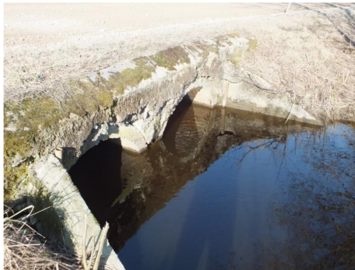
Foto 22. Binokkeltruup Saeveskikraavil (riigi poolt korrashoitav eesvool 4110150020000 valgala 35,8 km 2 ) 11176 Padise-Kurkse-Harju-Risti tee all enne (R/B truup) ja peale ümberehitamist (plast-truup). Liiga väikesed torud on paigaldatud liiga kõrgele tekitades maaparandus-süsteemis püsiva paisutuse, halvendades äravoolutingimusi üldiselt, suurendades üleujutuse tõenäosust ja tõkestades kalade rändetee. Oluliselt sobivam oleks olnud binokkeltruubi asendamine ühe suuremaavalise torusillaga, mille põhi oleks olnud voolusängiga samal kõrgusel. Mitmest torust koosnev truup ummistub suurema tõenäosusega
