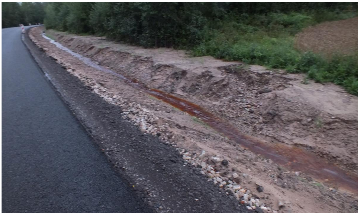
Foto 14. Põllult/metsast lähtunud koondunud veevool 90 Põlva - Karisilla tee kraavi, nõlv varisenud, pinnas minema uhutud. Sissevoolud ümbritsevatelt aladelt on mõistlik kindlustada võimalikult varakult
