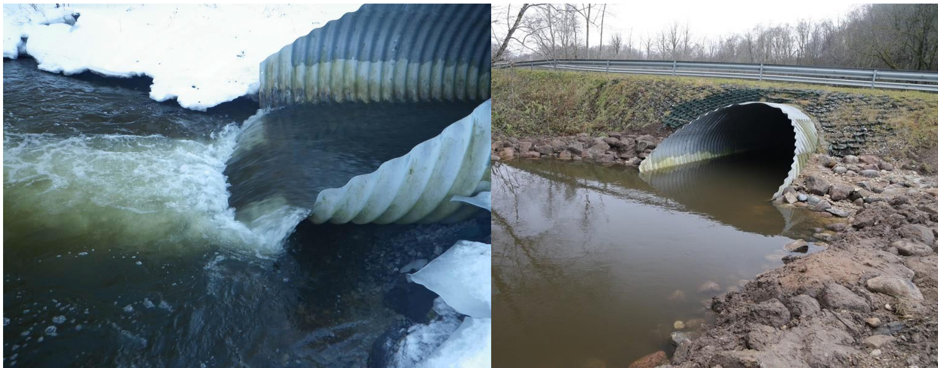
Foto 20. Torusild Toolse jõel 17172 Kunda Selja tee all enne ja peale ümberehitamist. Torusild on paigaldatud liiga kõrgele. Kalade rändeks vajalike tingimuste tagamiseks rajati truubi väljavoolule kärestik (täideti jõe põhja). Torusilla paigaldamise korral madalamale oleks saanud kulutusi kärestiku rajamiseks vältida, samuti oleks truubi poolt tekitatav paisutus jões väiksem. Praeguses olukorras tekitab truup jões alalise paisutuse
