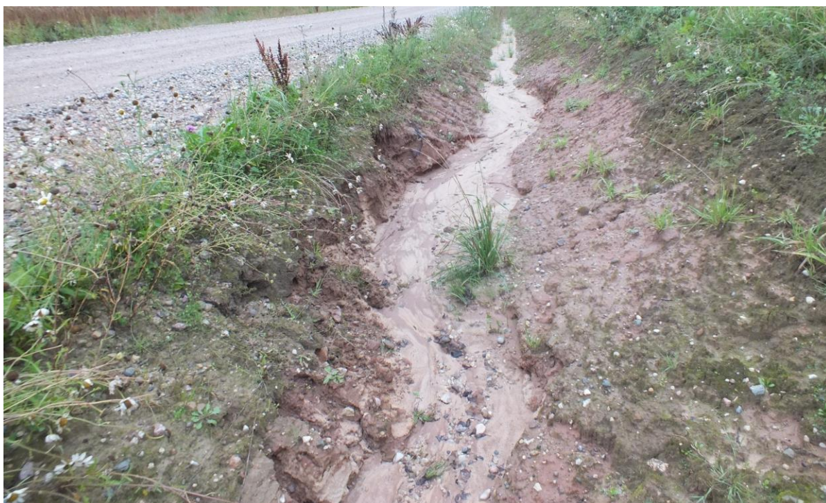
Foto 13. 18207 Niitsiku - Kahkva tee kraav, erosiooni tõttu nõlv varisenud, teekraavist välja kantud pinnas ummistab truupe ja eesvoolu (kraavid, ojad) settides takistab äravoolu nii teekraavidest kui ümbritsevatelt aladelt
