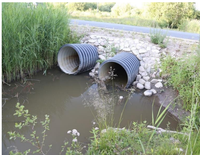
Foto 22. Binokkeltruup Saeveskikraavil (riigi poolt korrashoitav eesvool 4110150020000 valgala 35,8 km 2 ) 11176 Padise-Kurkse-Harju-Risti tee all enne (R/B truup) ja peale ümberehitamist (plast-truup). Liiga väikesed torud on paigaldatud liiga kõrgele tekitades maaparandus-süsteemis püsiva paisutuse, halvendades äravoolutingimusi üldiselt, suurendades üleujutuse tõenäosust ja tõkestades kalade rändetee. Oluliselt sobivam oleks olnud binokkeltruubi asendamine ühe suuremaavalise torusillaga, mille põhi oleks olnud voolusängiga samal kõrgusel. Mitmest torust koosnev truup ummistub suurema tõenäosusega
