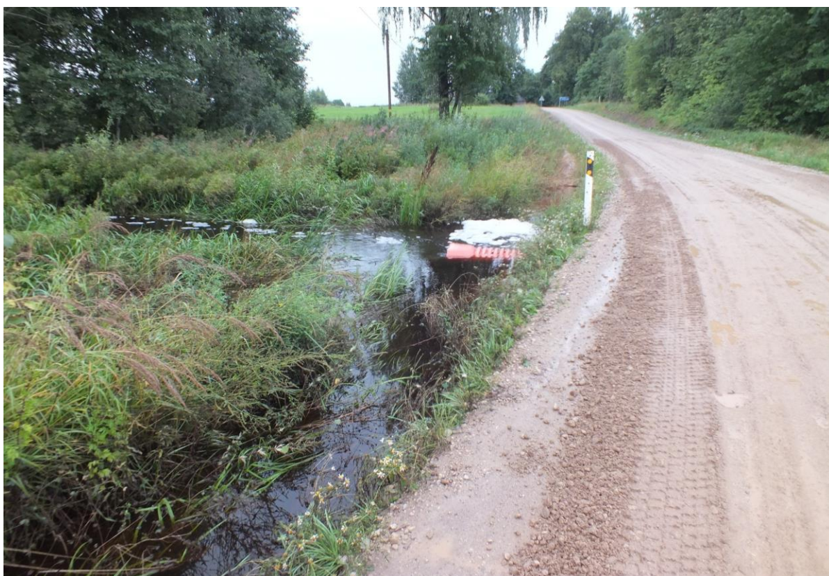
Foto 7. Truup 18207 Niitsiku - Kahkva teel, vee tase madalamas kohas peaaegu tee pinnani. Viinakuakraavil olev truup on paigaldatud liiga kõrgele ja paisutab vee tee mulde taha.
