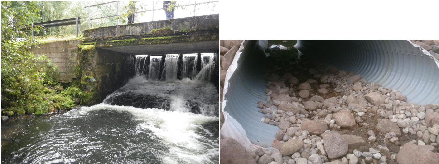
Foto 21. Torusild Ahja jõel 18111 Kiuma-Peraküla tee all. Endine Möksi veskipais ja Möksi sild on ümber ehitatud torusillaks. Toru põhi on sobiva languga, paigaldatud jõe põhjast madalamale ja toru on jõe põhja kõrguseni tagasi täidetud kividega. Tagatud on nii vee läbijuhtimine kui vee-elustiku rändevõimalus.
