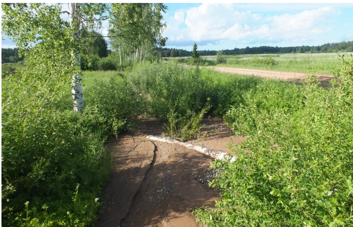
Foto 18. Tulvaveega teelt kaasa kantud materjaliga täitunud kuivenduskraav (ka teekraav). Oluline on materjal peale juhtumit võimalikult kiiresti veejuhtmest eemaldada
