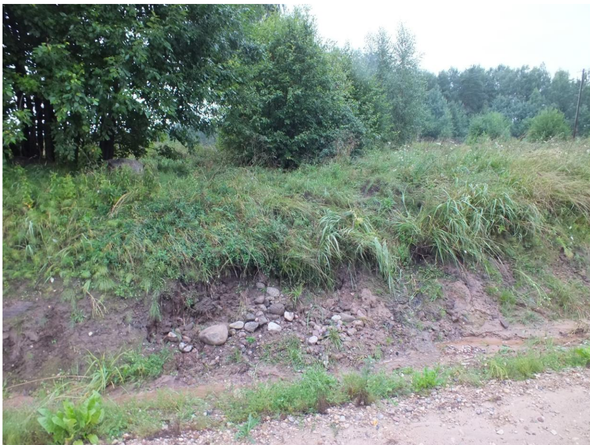
Foto 12. Põllult/metsast lähtuva kraavi suue 18207 Niitsiku - Kahkva tee kraavi, nõlv varisenud, teekraavi kantud pinnas takistab äravoolu
