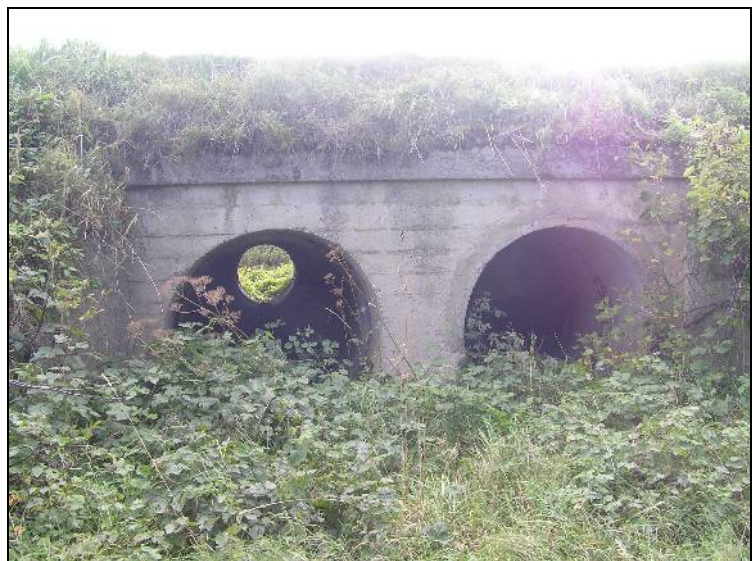
Foto 30. Kaksiktruup 38. kilomeetriposti juures. Pildil on näha, et truup on sirge ja teisest otsast paistev valgus ei peleta väikeulukeid truubist eemale.
