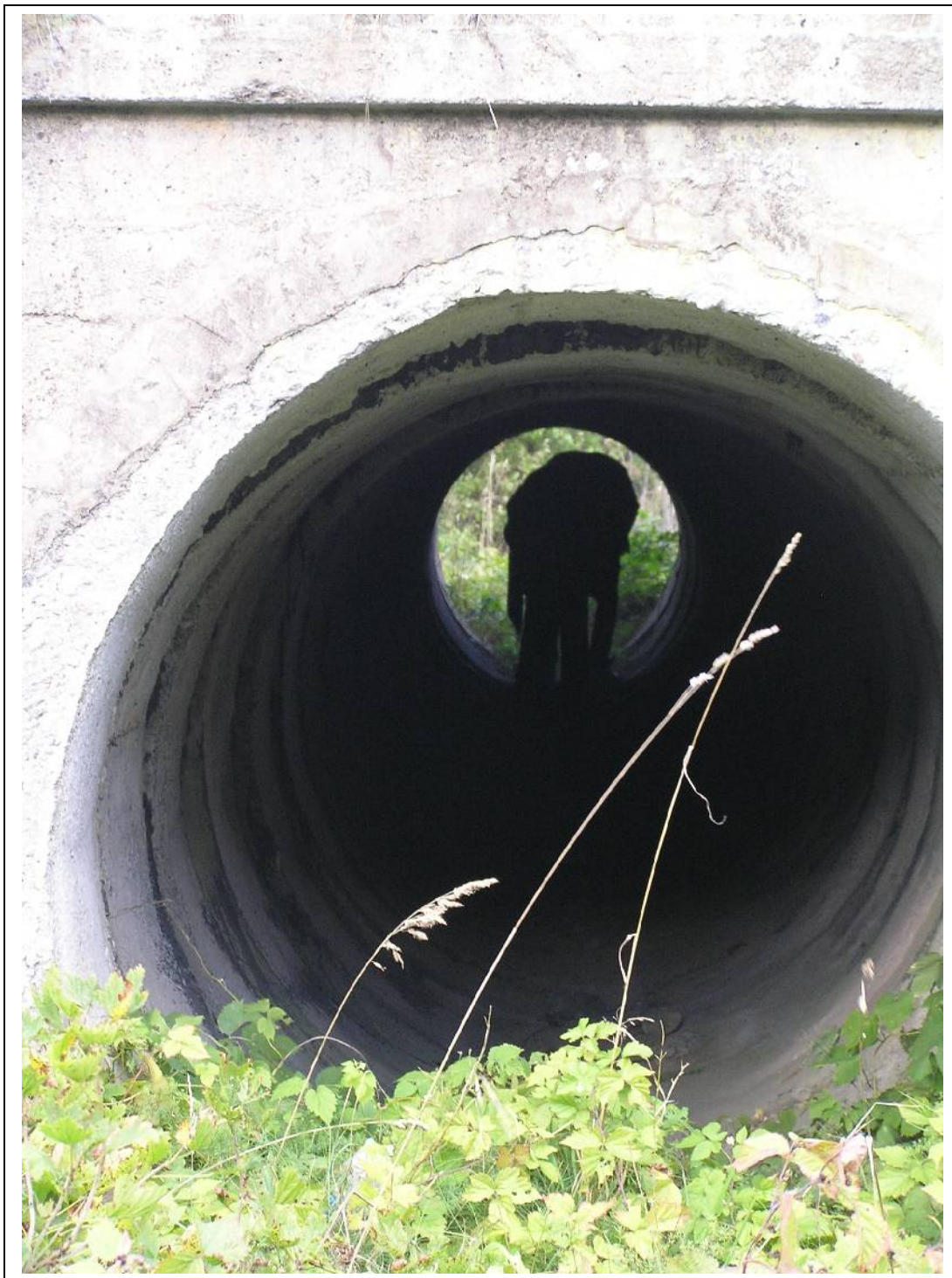
Foto 31. Kaksiktruup 38. kilomeetri lõpus. Truubi mõõtmed võimaldavad siin isegi inimesel küürutades tee alt läbi minna.
