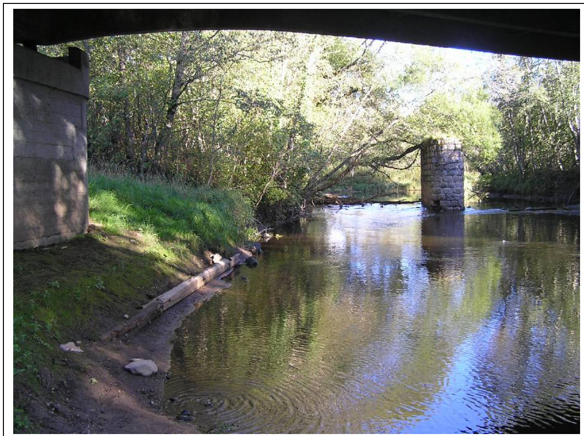
Foto 25. Vaade Pirita jõe Saula silla alt vana silla varemete suunas (ülesvoolu). On näha et uue silla alune kitsas kallasrada on suurevee ajal üle ujutatav ning vana silla postide juures ei ole kallasrada üldse. Selline kombinatsioon võimaldab siin liikuda vaid väga tolerantsetel väikeulukitel, nagu nt mink ja rebane.
