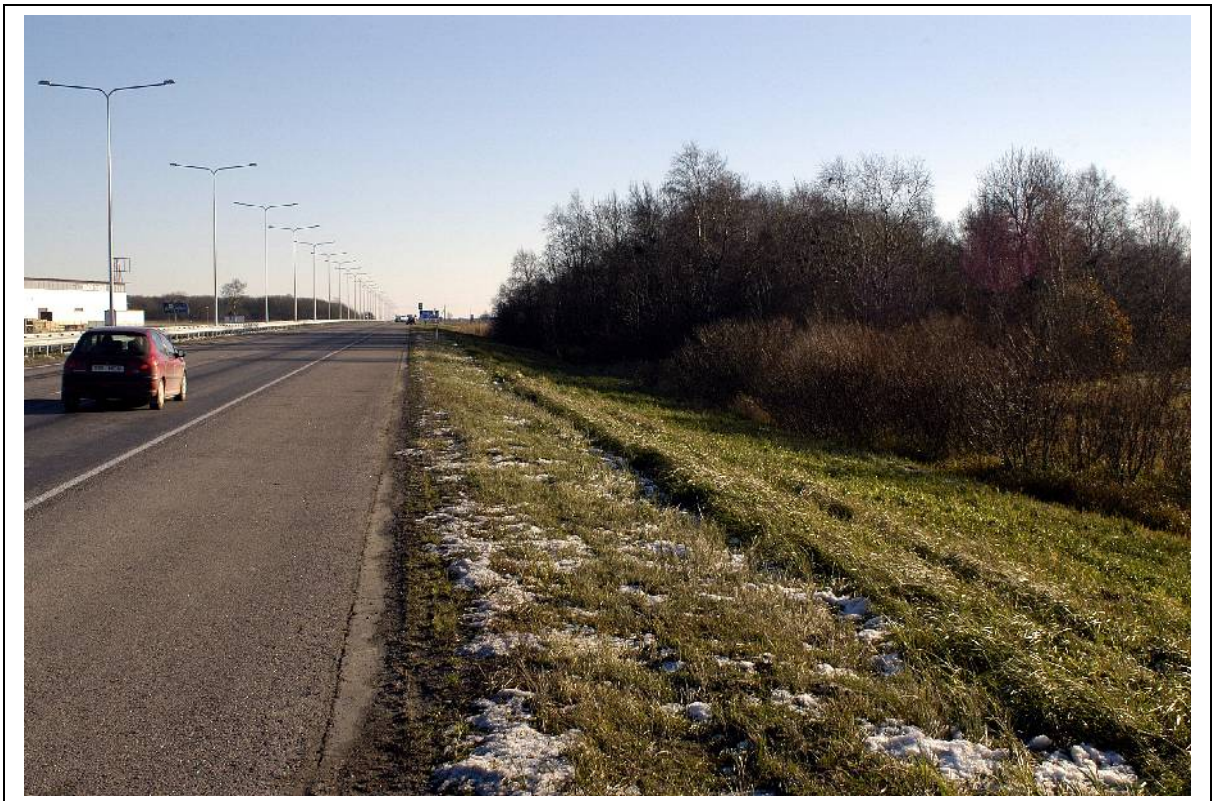
Foto 3. Vaade 11. kilomeetrilt Tartu suunas. Paremalt on näha metsariba, kust loomade läbipääs peab viima vasakul uue ärihoone eest läbi, ca 200 m kaugusel teest jätkuva puisturibani.
