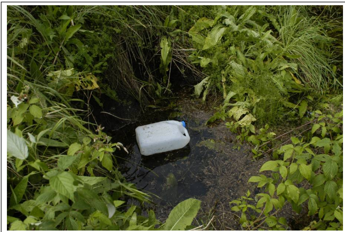
Foto 20. Sausti peakraavi trüüp on ummistunud ja mattunud. Trüübi esine lisaks kasutusel prügipaneku kohana. Et trüübist saaks siin läbipääs väikeulukitele on vaja suuri ümberkorraldusi.
