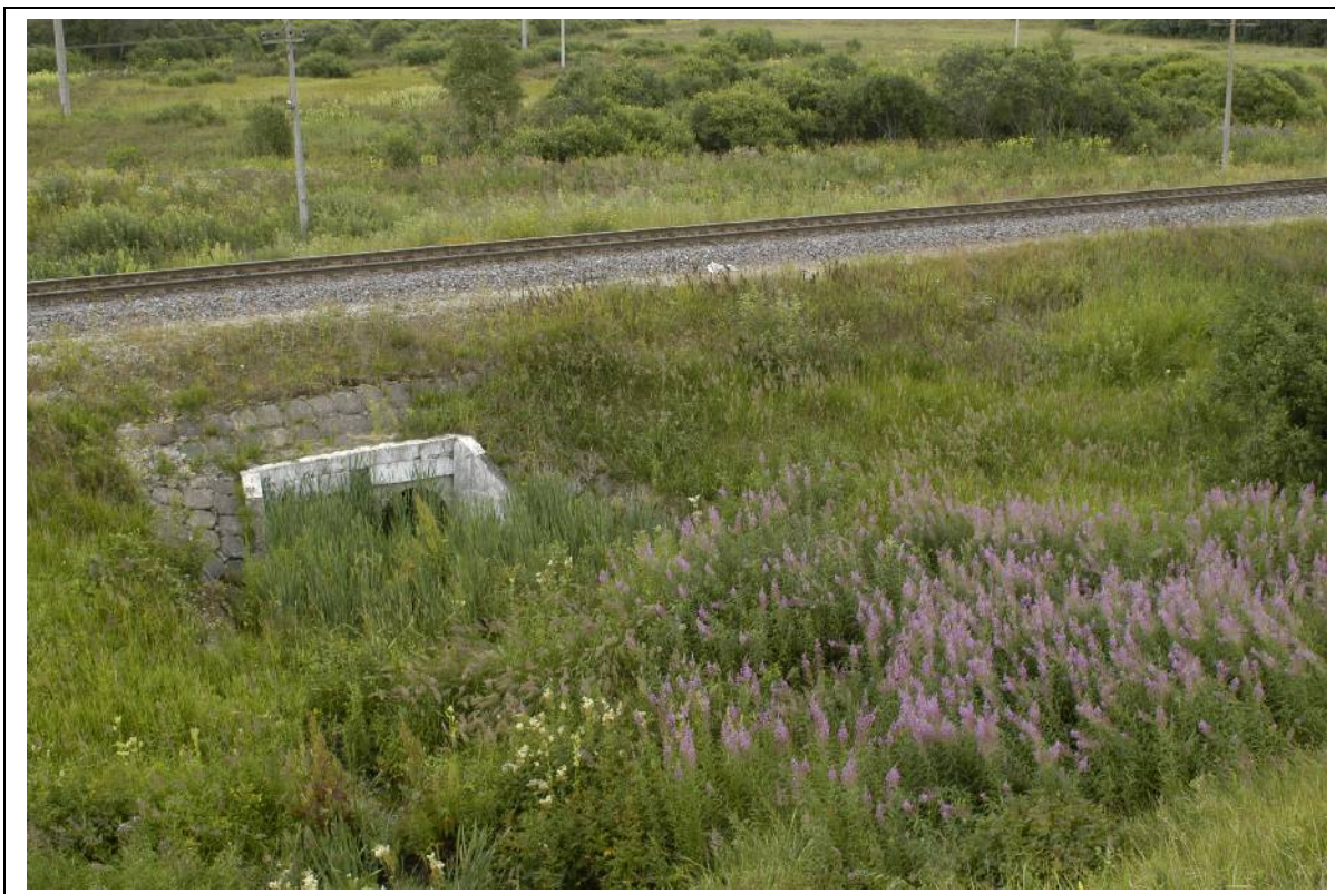
Foto 6. Vaade Lagedi viadukti tammilt Lagedi suunas umbes sellest kohast kuhu võiks rajada metskitsede läbipääsu.
