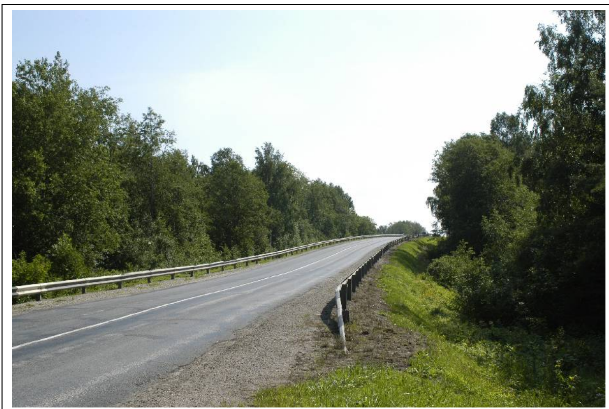
Foto 36. Vaade Valingu viaduktile Keila suunast. Pildil olevat kõrget teetammi pikendades oleks siin võimalik luua metskitsedele läbipääs.
