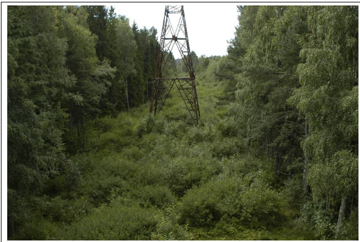
Foto 30. Paralleelselt raudteega kulgev elektriliin, mis võiks Saku viadukti piirkonnas olla lahenduseks loomade suunamisel, pikendades viadukti elektriliinini ja tarastades selle raudteepoolse serva.
