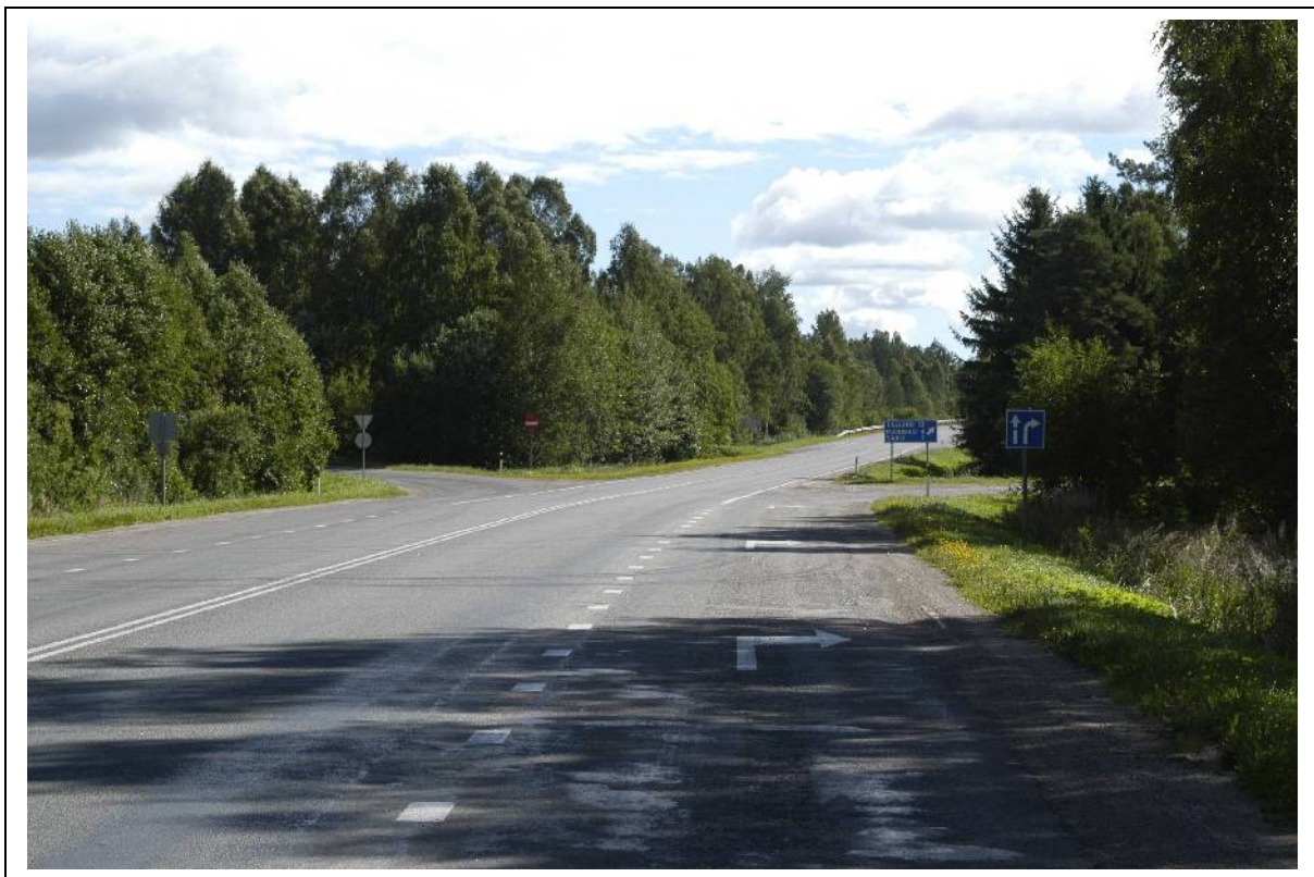
Foto 25. Vaade Saku viadukti tammilt piki Tallinn ringteed Keila suunas. Esiplaanil on näha liiklussõlmes loomaõnnetuse ohtu suurendavad peale- ja mahasõiduteed.
