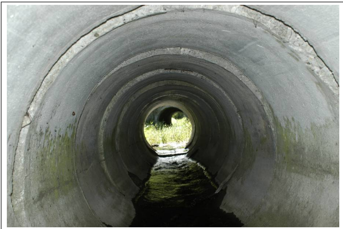
Foto 16. Kurna-Mõisaküla truup sobiks väikese kohandamise (kallasraja tekitamine) hästi ka väikeulukite läbipääsuks.
