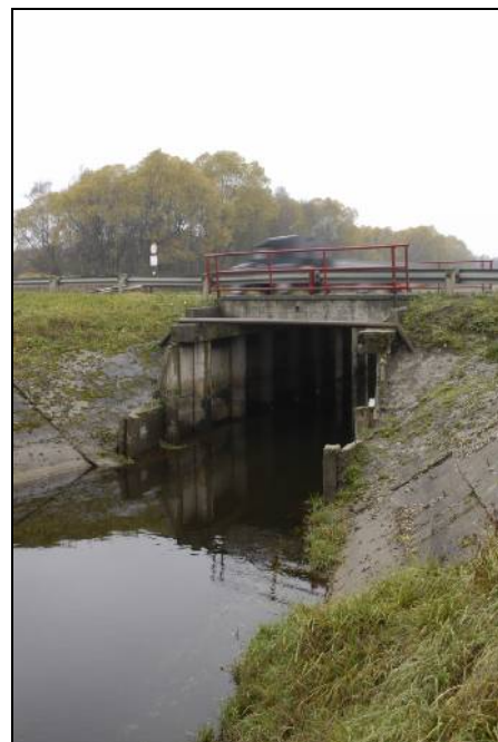
Foto 9. Pirita-Ülemiste kanali sild, nagu see on praegu ei sobi ulukite läbipääsuks, kuna silla all puuduvad kallasrajad ning sild ise on ka suhteliselt madal.
