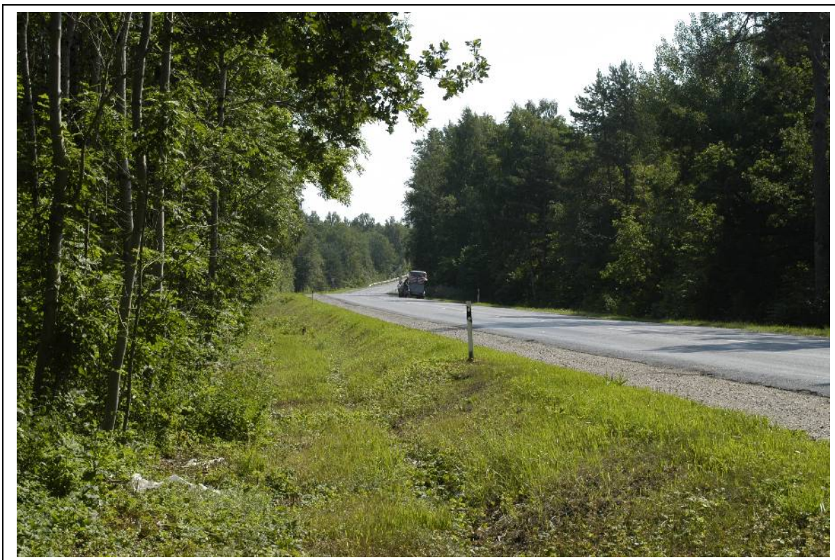
Foto 32. Vaade Valingu viadukti algusele Keila poolt. Just pildil oleval lõigul on aktiivseim metskitsede teeületuskoht.
