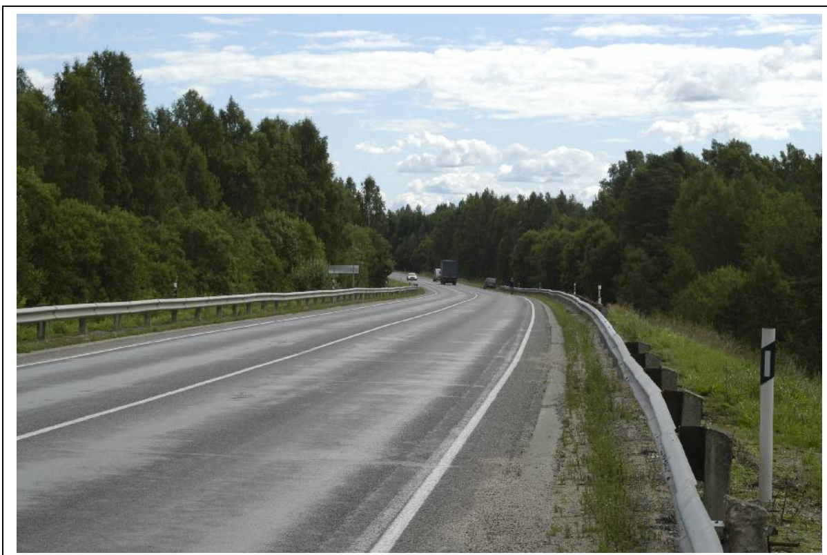
Foto 23. Tõus Saku viadukti tammile Tallinna ringtee 24. kilomeetril.
