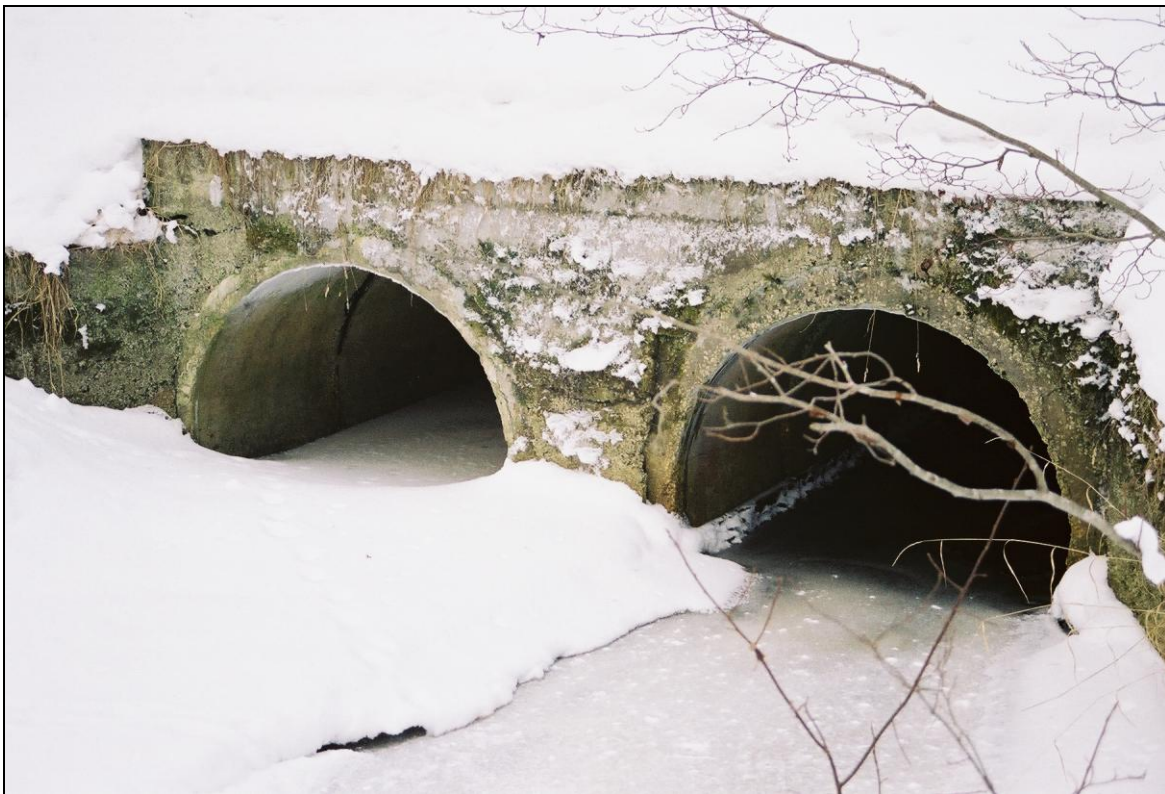
Foto 12. Näide vett täis ümmarguse ristlõikega truubist (Tallinn-Narva mnt 50ndal kilomeetril), mida ulukid ei saa kasutada ja mille kõrvalt kõrgelt piiretega varustatud teetammilt nad järsku teele satuvad, põhjustades liiklusohu.
