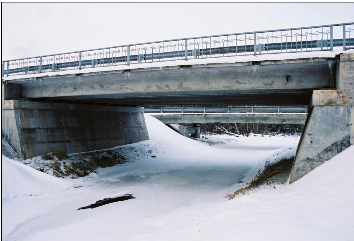
Foto 9. Vaade Loobu jõe silla alt läbi lõunast põhja suunas. Pildil on näha et tõenäoliselt kaovad kitsad kallasrajad silla all kõrgema veeseisuga täiesti ja ei ole seetõttu kasutatavad ulukite poolt. Samuti varjab madal sild ja nurga all lõikuv jõgi vaatevälja teisel pool teed, mida soodustab ka jõeäärne mets. Siin võiks aidata silla alla kallasradade tekitamise, mis paikneksid piisavalt kõrgel, et kõrgveega mitte veepinna alla jääda ja samas oleksid piisavalt tugevad, et jääminek ja suurvesi neid ära ei viiks.
