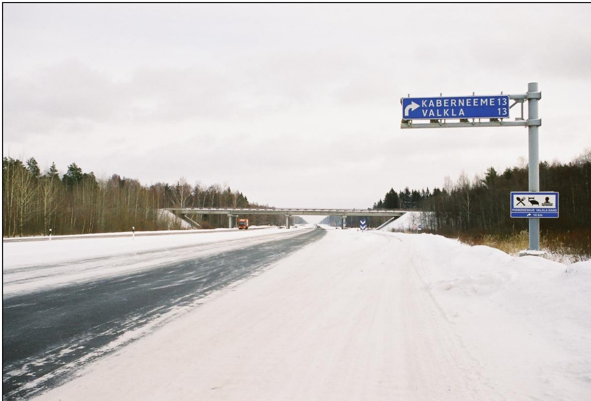
Foto 3. Vaade Aegviidu kahetasandilisele ristmikule. Pildil on näha maantee lisarajad ja laienemine, pildilt jäävad välja maha ja pealesõiduteed, mis koos viaduktiga moodustavad ulukitele olulise takistuse ja suunavad nad mõlemale poole ristmikku teed ületama.
