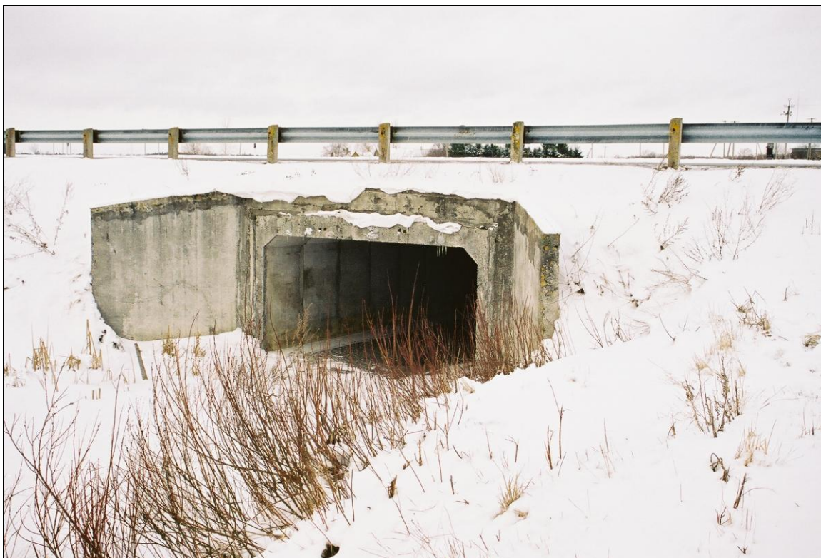
Foto 7. Vaade karjatunneli suudmele 33ndal kilomeetril lõuna poolt. Pildil on näha et tunnel paikneb lagedal ja on kõrguselt ning haljastuse puudumise tõttu ehk äärmisel juhul kasutatav vaid rebase või kähriku poolt. On kaheldav kas metskits seda tunnelit kasutaks, kindlasti aga mitte põder.
