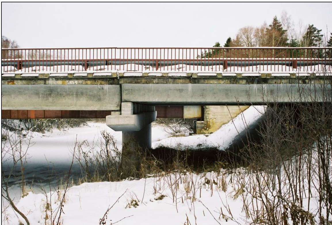
Foto 5. Vaade Jägala jõe silla alt põhja suunas. Pildil on näha Jägala et vanal sillal puudub piisav kal-lasrada ja et juba inimese silmade kõrguselt pole võimalik silla alt läbi näha, rääkimata suurulukitest, nagu põder. Samuti puudub silla all varjevõimalusi pakkuv haljastus, mis on oluline väikeulukitele.
