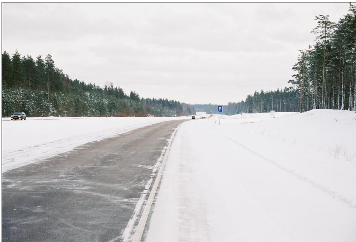
Foto 11. Vaade 59ndale kilomeetrile, Valgejõe silla suunas. On näha et piirkonnas asub tee süvendis, mis võimaldaks ehitada ulukite ülepääsu ehk ökodukti. Samas on pildil näha hea näide avatud vaatest teeservades, ulukite liikumine autojuhile juba kaugelt nähtav.
