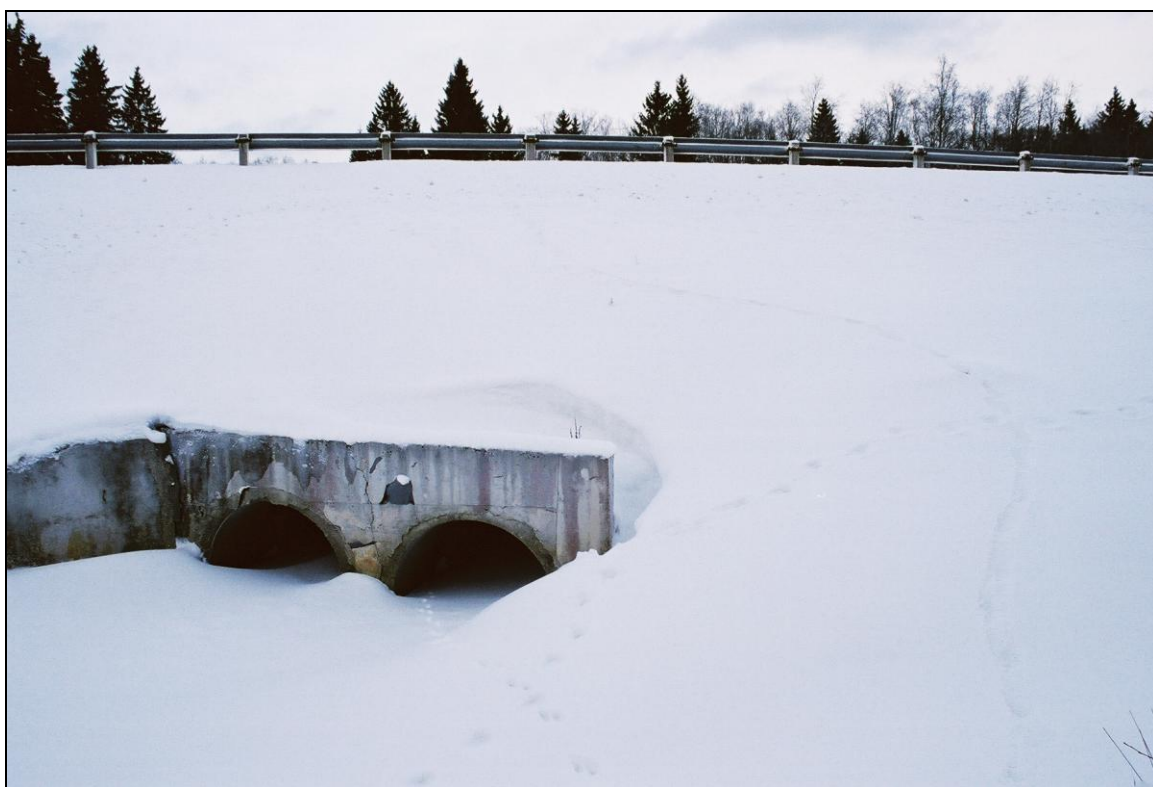
Foto 8. Vaade Läsna jõe kaksiktruubi lõunapoolsele avale 69ndal kilomeetril. Pildil on näha et väikeulukid on truubi kõrvalt üle tee läinud, kusjuures autojuhi jaoks varjab teele sattuvat ulukit kõrge tamm ja teepiire. Ulukid kasutaks truupi kui see oleks nelinurkse ristlõikega ja omaks kuiva kallasrada, samuti võiks ulukeid truupi juhtida põõsariba.
