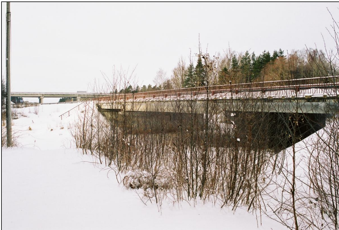
Foto 4. Vaade Aegviidu kahetasandilisele ristmikule Jägala jõe silla juurest. Pildil on näha Jägala jõe sügav org, mis ei sobi suurulukitele liikumiseks. Samas on lõikab viadukti lähedus tee silla kõrvalt ära.
