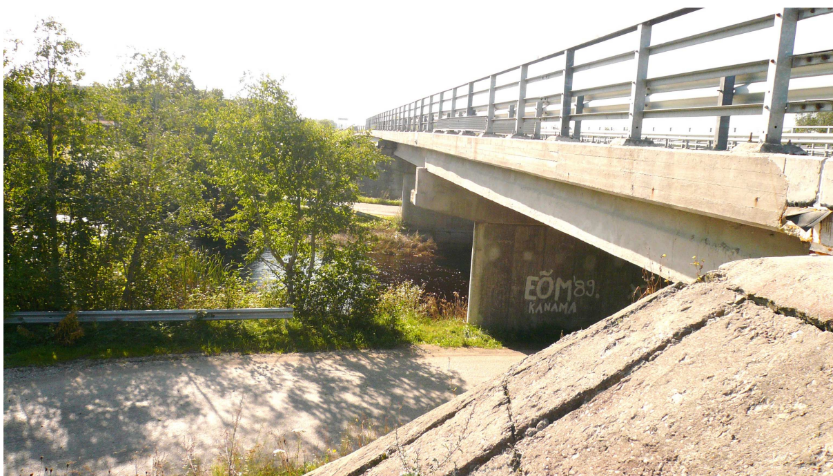
Foto 3. Jõgisoo sild 23. kilomeetril. Näha on silla alt läbi kulgev liiklussõlme ramp
