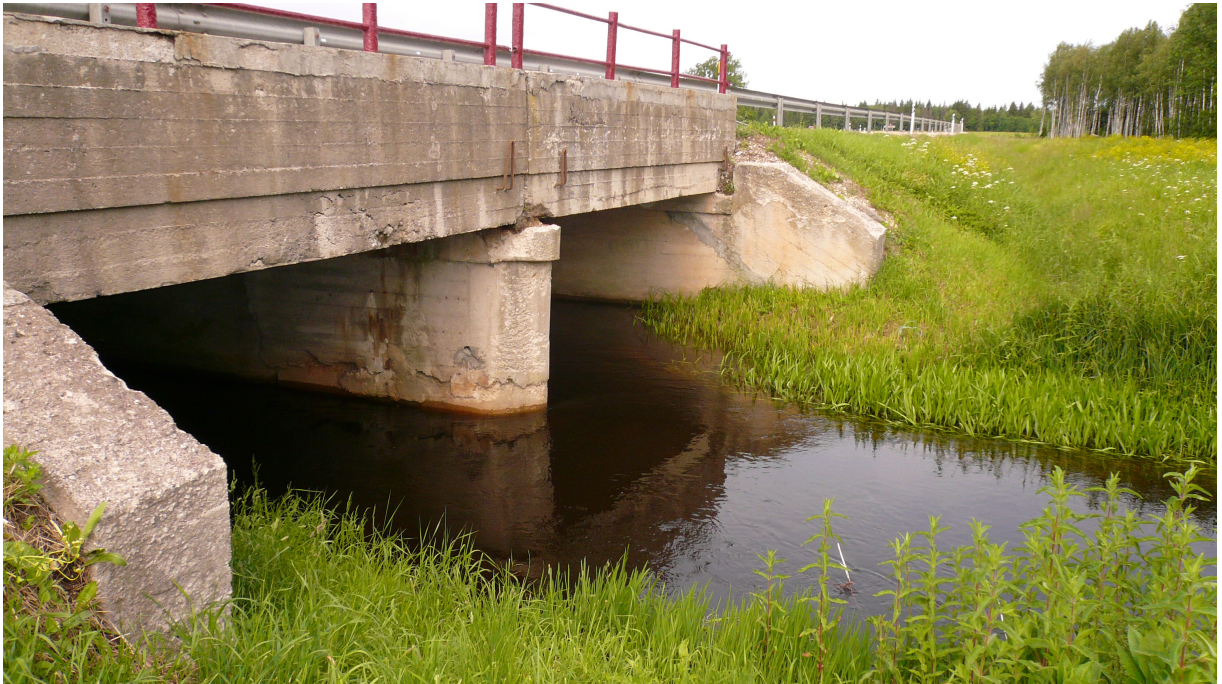
Foto 1. Põhjaka sild Esna jõel ei ole loomadele enamuse osa aastast heaks läbipääsuks, kuna puudub kuiv kallasrada.
