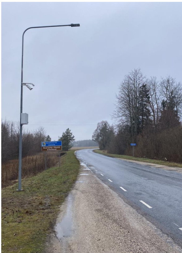
Joonis 13. Teeilmajaam ja teekaamera „Sutlepa“ paigaldatuna tänavavalgustuse postile
