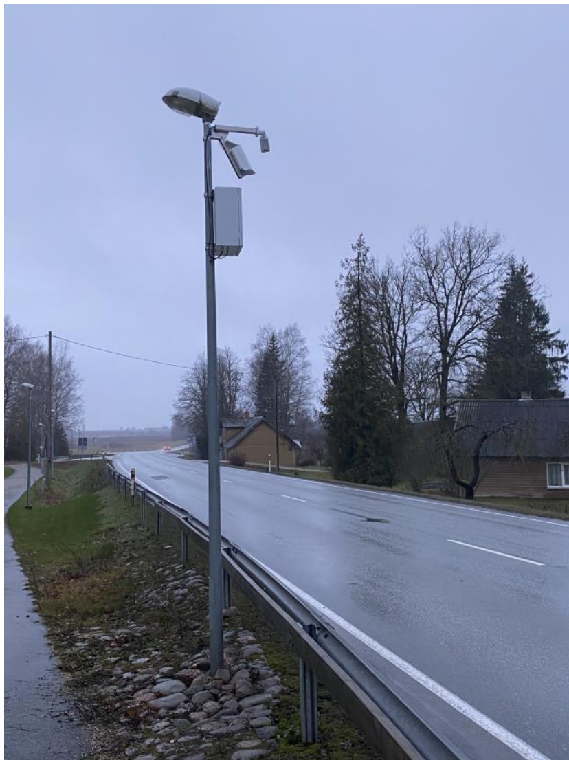
Joonis 10. Teeilmajaam ja teekaamera „Laiusevälja“ paigaldatuna tänavavalgustuse postile
