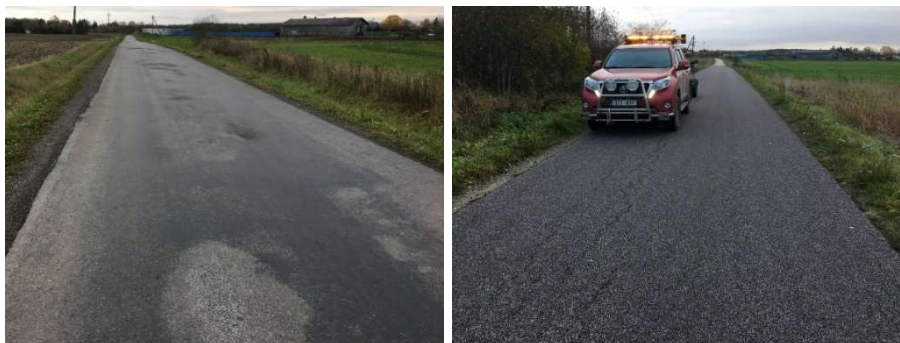
Fotod 3.6 ja 3.7. Pajupea tee külmakerkeline sektsioon. Vesiroosi teel leidus hulgaliselt võrkpragusid.
