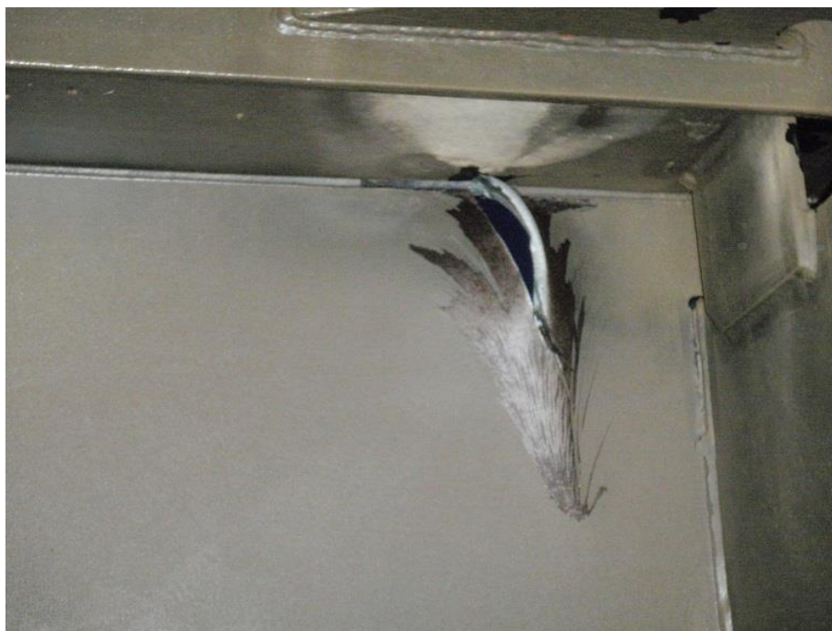
Foto 4 MT SONGA CORAL vigastus. Vaade tanki Nr.3 seest.
